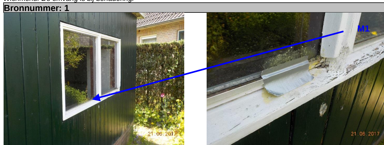
Kit in kozijn van houten garage
