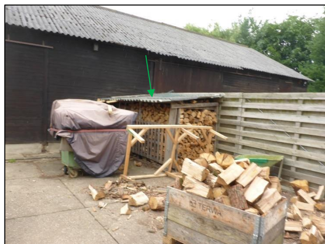
Foto 24: Houtopslag: Golfplaten dak (M05V)
