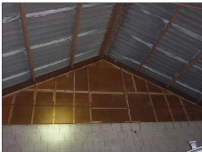
Foto 21: Schuur 2: Binnenzijde dak
