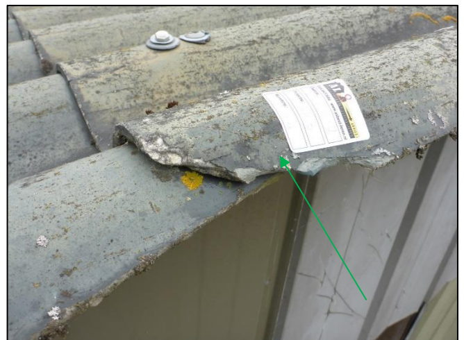
Foto 6: Schuur 1: Golfplaten dak (M03V)
