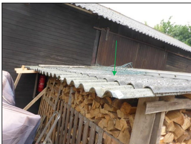
Foto 23: Houtopslag: Golfplaten dak (M05V)
