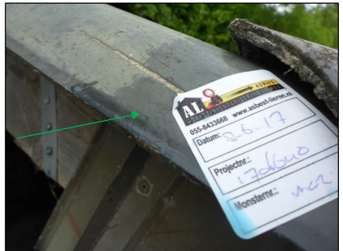
Foto 4: Schuur 1: Golfplaten dak (M02V)
