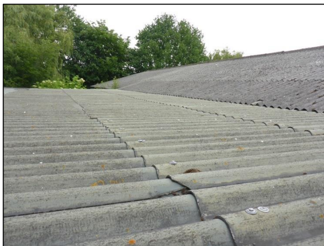
Foto 7: Schuur 1: Golfplaten dak
