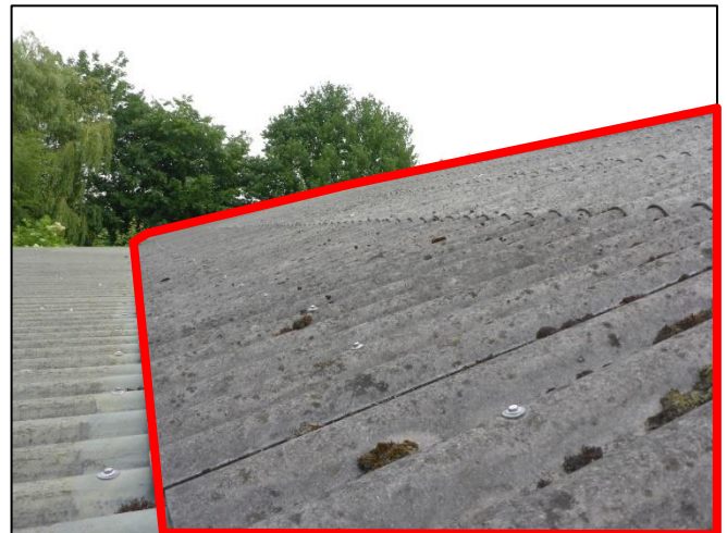
Foto 16: Schuur 2: Golfplaten dak incl. nok (M04AA)
