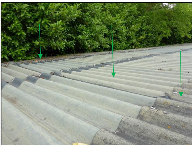
Foto 5: Schuur 1: Golfplaten dak (M01V & M02V & M03V)
