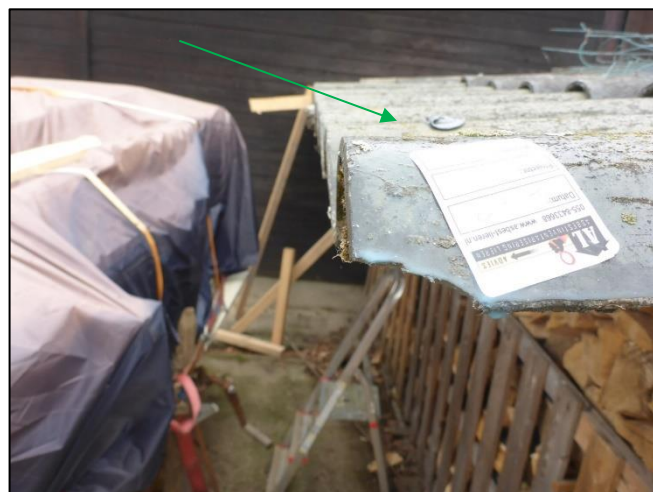
Foto 22: Houtopslag: Golfplaten dak (M05V)
