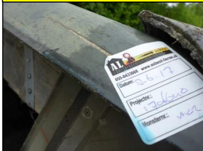
Schuur 1: Golfplaten dak (M02V)
