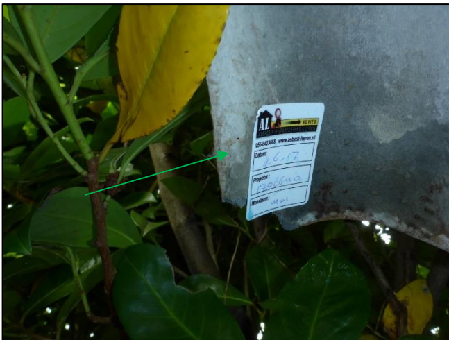
Foto 3: Schuur 1: Golfplaten dak (M01V)
