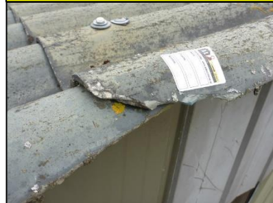
Schuur 1: Golfplaten dak (M03V)
