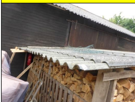
Houtopslag: Golfplaten dak (M05V)
