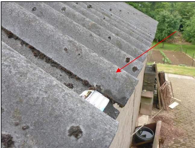
Foto 15: Schuur 2: Golfplaten dak incl. nok (M04AA)
