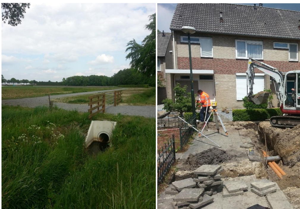
Abbeelding 2 retentievoorziening Veilig Oord (links) en reconstructie Gerard Bruninglaan (rechts).
