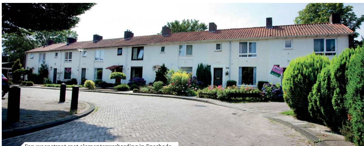
Een woonstraat met elementenverharding in Enschede.
