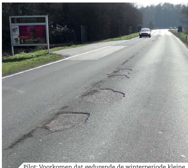
Pilot: Voorkomen dat gedurende de winterperiode kleine beschadigingen uitgroeien tot forse beschadigingen en duurder onderhoud. Dit door weginspecties en kleine herstelwerkzaamheden voor de winter al uit te voeren.
