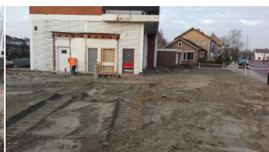
Foto 5: aangebrachte leeflaag
