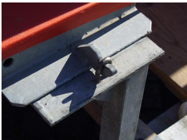
Foto 11 en 12 rechterzijde stoelentrio met klemverbinding gezekeerd. De verankert bij doorgaande stoelenrij ook de linkerzijde. Bij linkse beëindiging wordt gezekeerd met bout en moer.
