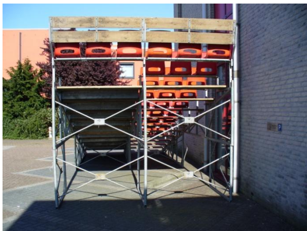
Foto 2 Achteraanzicht met duidelijk de stabiliteitskruizen en de veiligheidsplank achter de bovenste zitpositie's. Bij de buitenste tribune wordt middels steigerbuizen een leuning gecreëerd
