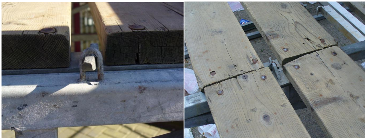
Foto 13, plankenvloer linkerzijde gezekeerd met haak, midden en rechterzijde met spie
