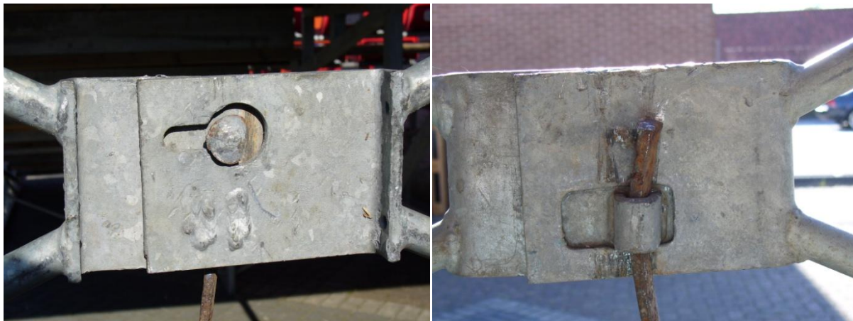
Foto 3 en 4, De stabiliteitskruizen zijn dubbel gezekerd. 1x met stalen spie, 1x met sleutelgat verbinding
