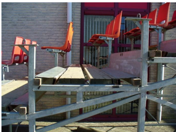
Foto 9 en 10, Detail plankenvloer en stoelen op console
