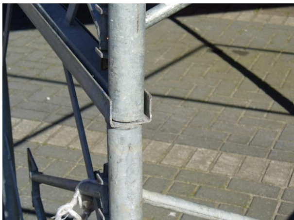
Foto 8, Spant op 1 meter hoogte module. Zowel spant als hoogtemodule zijn voorzien van stabiliteitskruis
