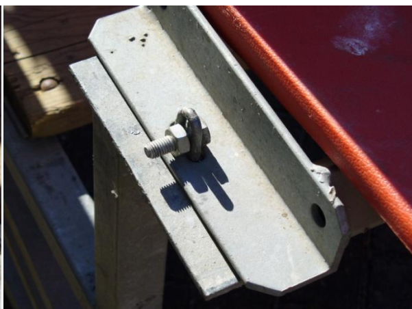
Foto 11 en 12 rechterzijde stoelentrio met klemverbinding gezekeerd. De verankert bij doorgaande stoelenrij ook de linkerzijde. Bij linkse beëindiging wordt gezekeerd met bout en moer.
