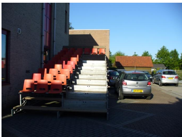
Foto 1 Overzicht van de ingemeten tribune met trap en zitgedeelte Breedte 2x 1500; lengte 2 modules van 3950
