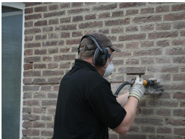
Figuur 14: Gebruik PBM's bedrijf 2; uithakken met hakhamer.
