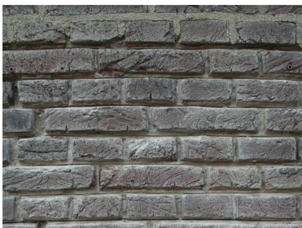
Figuur 7: Proefvak bedrijf 1 na het uithakken.
