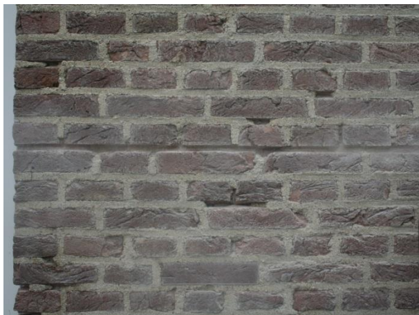
Figuur 16: Proefvak bedrijf 2 voor het uithakken
