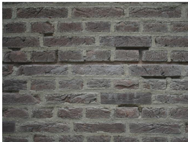
Figuur 17: Proefvak bedrijf 2 begin uithakwerkzaamheden.
