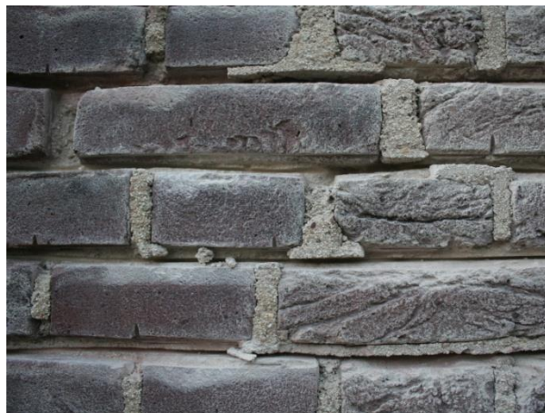
Figuur 6: Proefvak bedrijf 1 tijdens het uithakken.
