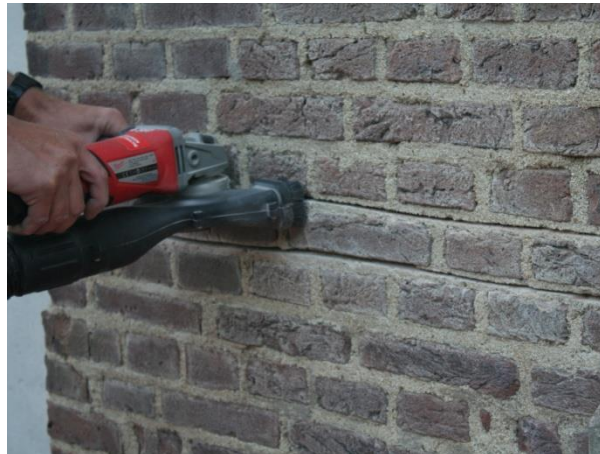
Figuur 5: De stofafzuiging is aangesloten aan de zaag.
