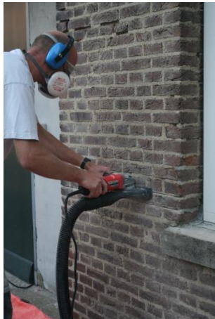
Figuur 4: Voeg eerst inzagen met een diamantzaag om de stenen niet te beschadigen.
