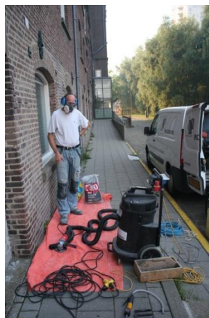
Figuur 3: Werkplaatsinrichting en voorbereiding. Er wordt volop voldaan aan de geldende VGM-eisen.
