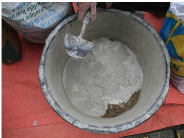
Figuur 9: Aanmaken van de mortelreceptuur.
