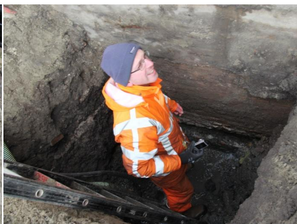
Figuur 13: Funderingsonderzoek door inspecteur.
