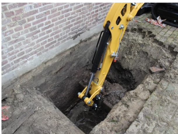
Figuur 12: Het graven van een inspectieput
