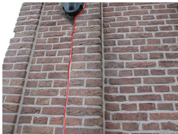
Figuur 6.66: Een scheur a.g.v. dilatatie/ thermische krimp
