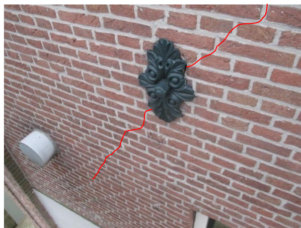
Figuur 6.70: Een scheur a.g.v. dilatatie/ thermische krimp
