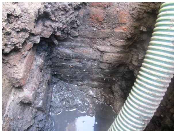
Figuur 25: Funderingsinspectieput 1; metselwerk circa 1,8 m onder het maaiveld.
