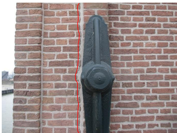
Figuur 6.67: Een scheur a.g.v. dilatatie/ thermische krimp
