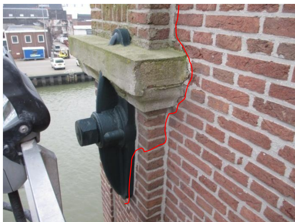
Figuur 6.65: Een scheur a.g.v. dilatatie/ thermische krimp.
