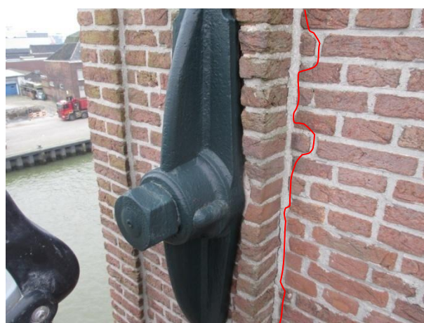
Figuur 6.58: Een scheur a.g.v. dilatatie / thermische krimp.
