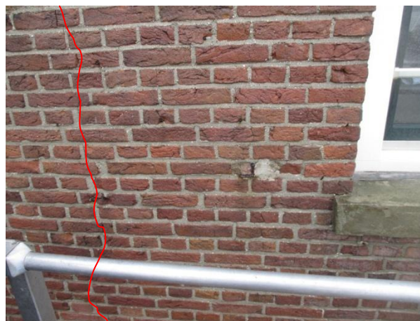
Figuur 6.96: Corroderende oude bevestigingsmiddelen.
