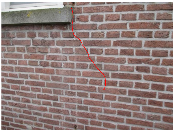
Figuur 6.77: Een scheur a.g.v. dilatatie/thermische krimp.
