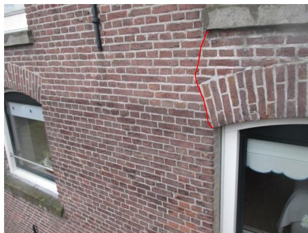
Figuur 6.14: Een scheur a.g.v. dilatatie/ thermische krimp.
