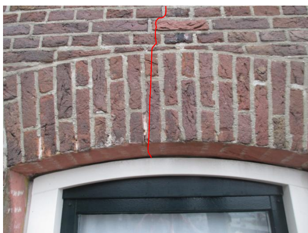
Figuur 6.123: Scheur a.g.v. en dilatatie/thermische krimp.
