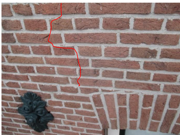
Figuur 6.61: Een scheur a.g.v. dilatatie/thermische krimp.
