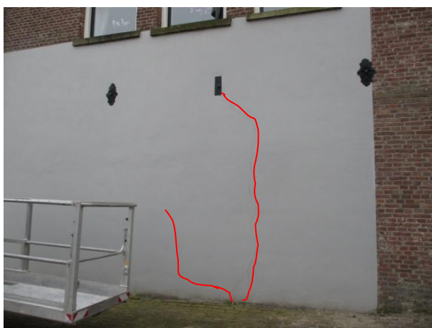
Figuur 6.81: Scheuren a.g.v. dilatatie/thermische krimp.
