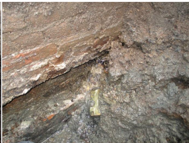
Figuur 23: Funderingsinspectieput 1; metselwerk circa 1,8 m onder het maaiveld.
