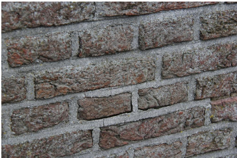
Figuur 15: 2 de generatie voegen niet gedegrademd, wel op veel plaatsen losgekomen maar niet uitgevallen.
