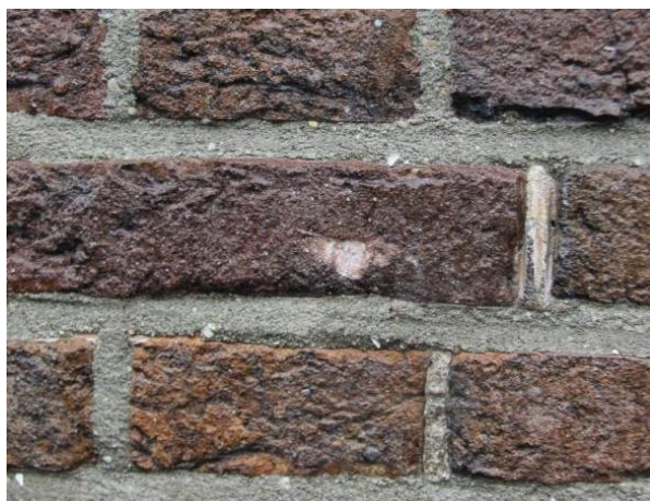
Figuur 18: Sprenkeltest met weggeschrapt stukje baksteenheid: actieve hydrofobeerbehandeling.
