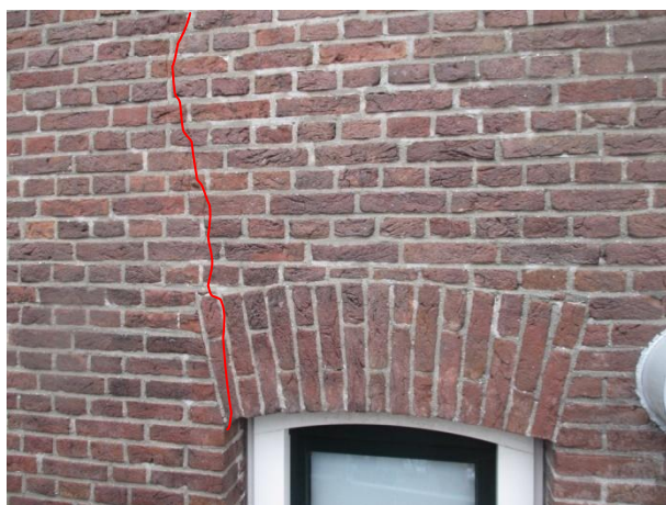
Figuur 6.111: Scheur a.g.v. dilatatie/thermische krimp.
