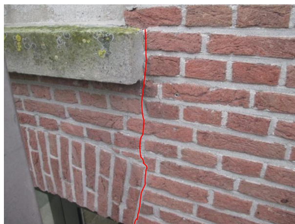
Figuur 6.76: Een scheur a.g.v. dilatatie/thermische krimp
