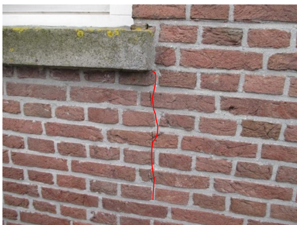
Figuur 6.63: Een scheur a.g.v. dilatatie/thermische krimp.
