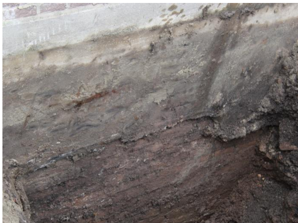
Figuur 22: Funderingsinspectieput 1; waterdichte pleisterlaag tot en met 1 m onder het maaiveld.
