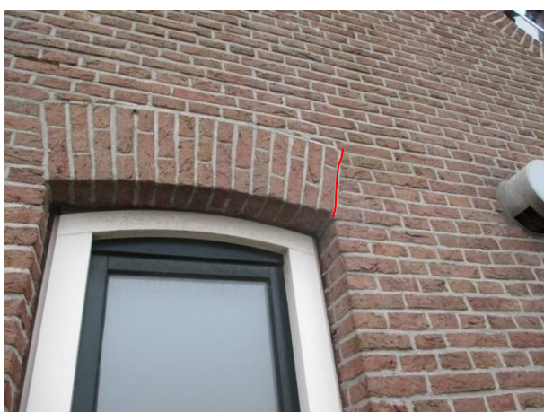
Figuur 6.43: Een scheur a.g.v. dilatatie/thermische krimp.
