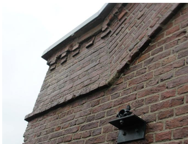
Figuur 19: Glans is een indicatie voor een actieve hydrofobeerbehandeling.
