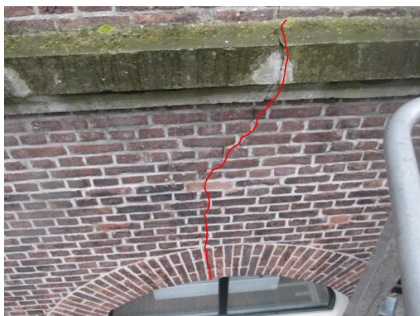
Figuur 6.21: Scheur a.g.v. dilatatie / thermische krimp.
