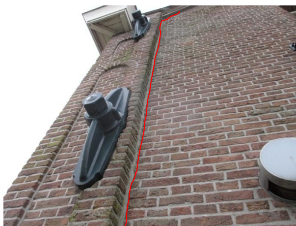
Figuur 6.44: Een scheur a.g.v. dilatatie/thermische krimp.
