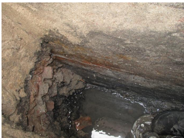
Figuur 24: Funderingsinspectieput 2; waterdichte pleisterlaag tot en met 1 m onder het maaiveld.
