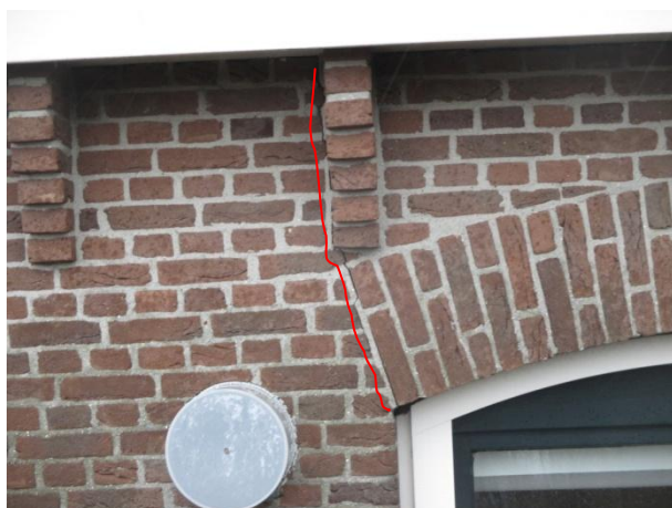
Figuur 6.11: Een scheur a.g.v. dilatatie/thermische krimp.
