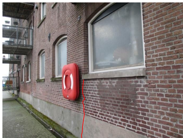
Figuur 6.85: Scheuren a.g.v. dilatatie/thermische krimp.
