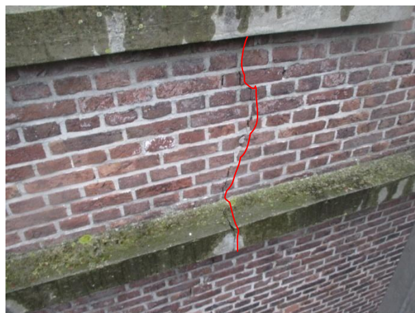
Figuur 6.20: Scheur a.g.v. dilatatie / thermische krimp.
