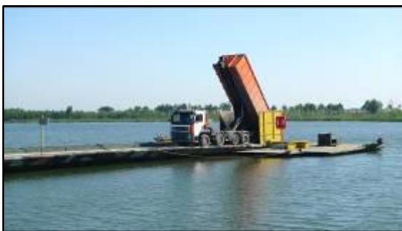
Figuur 8: Toepassen via pontonbrug.
