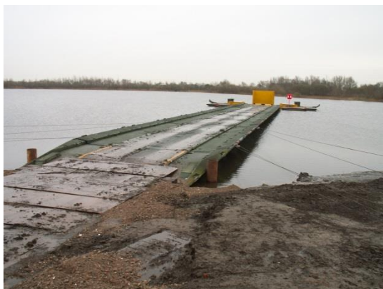
Figuur 2: Pontonbrug
