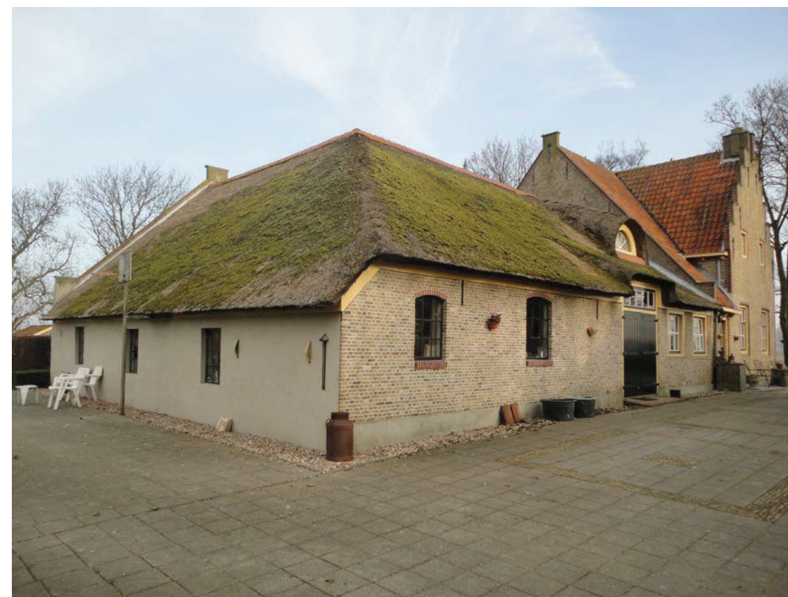
02. Zuidwest- en zuidoostgevel
