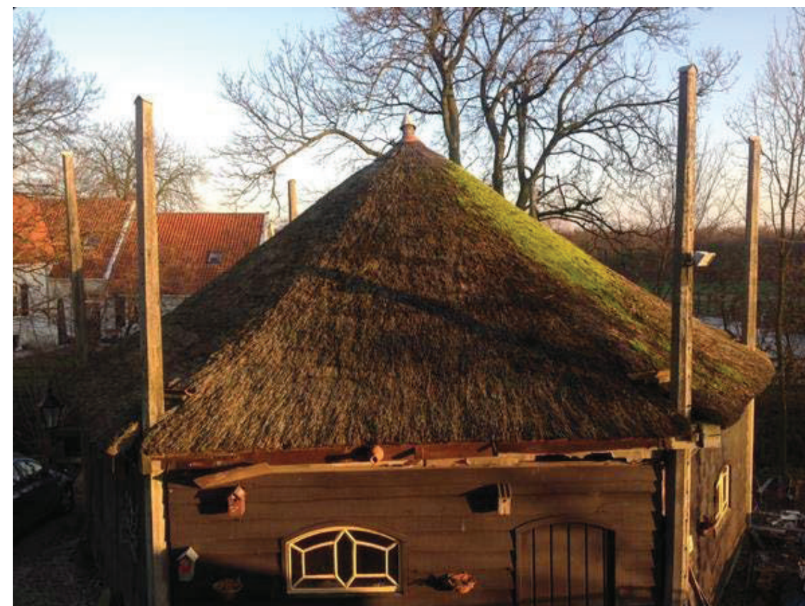
06. Noordwestzijde dak vanuit dakraam stal
