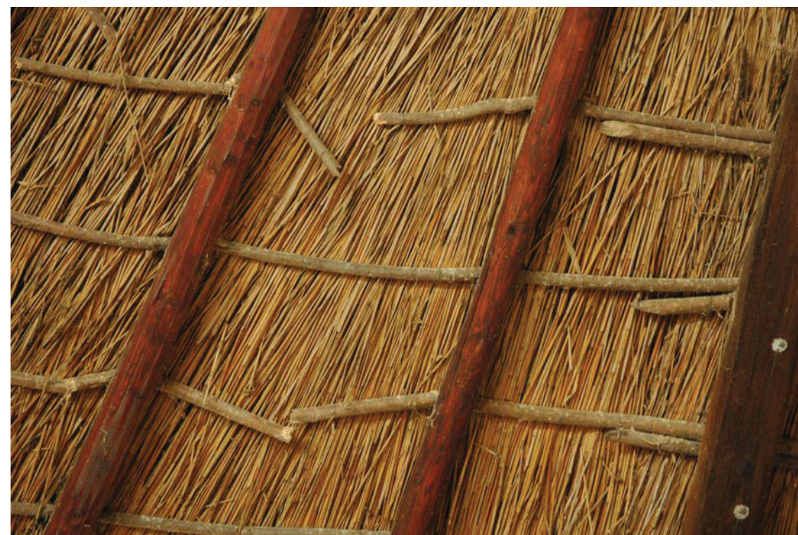
11. Gebroken wilgentenen rietlatten
