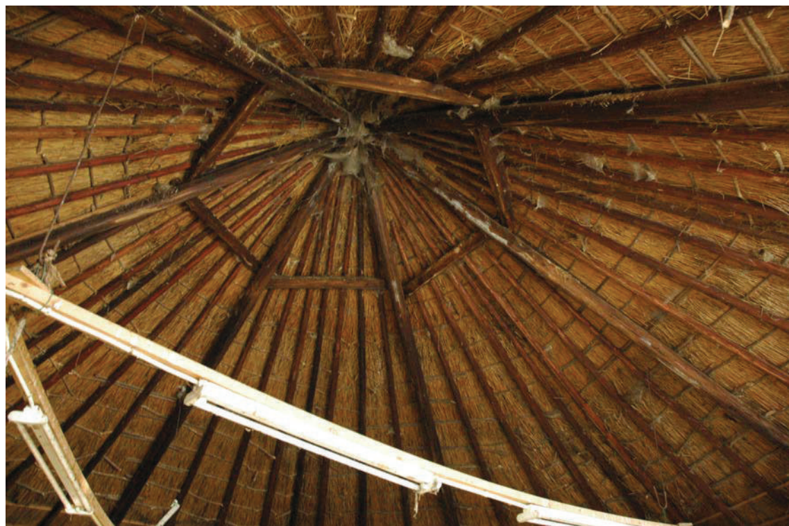
08. Binnenzijde van de kap van de hooiberg
