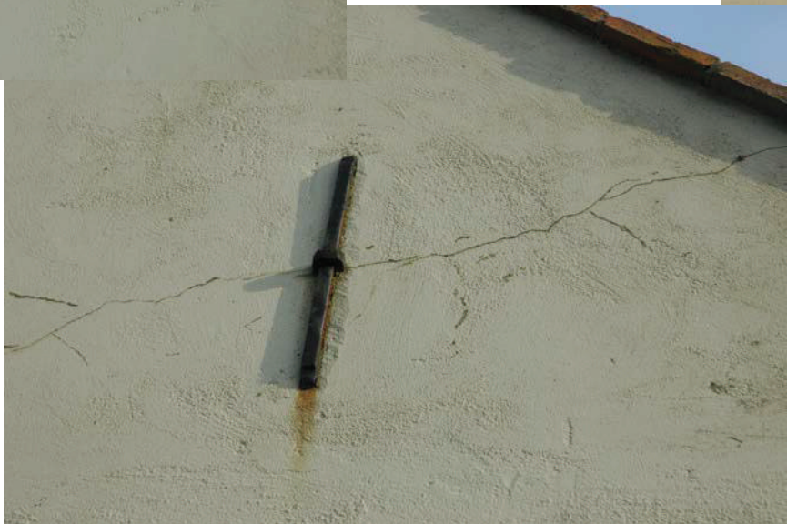
23. Noordwestgevel - scheuren in stucwerk, roestend anker
