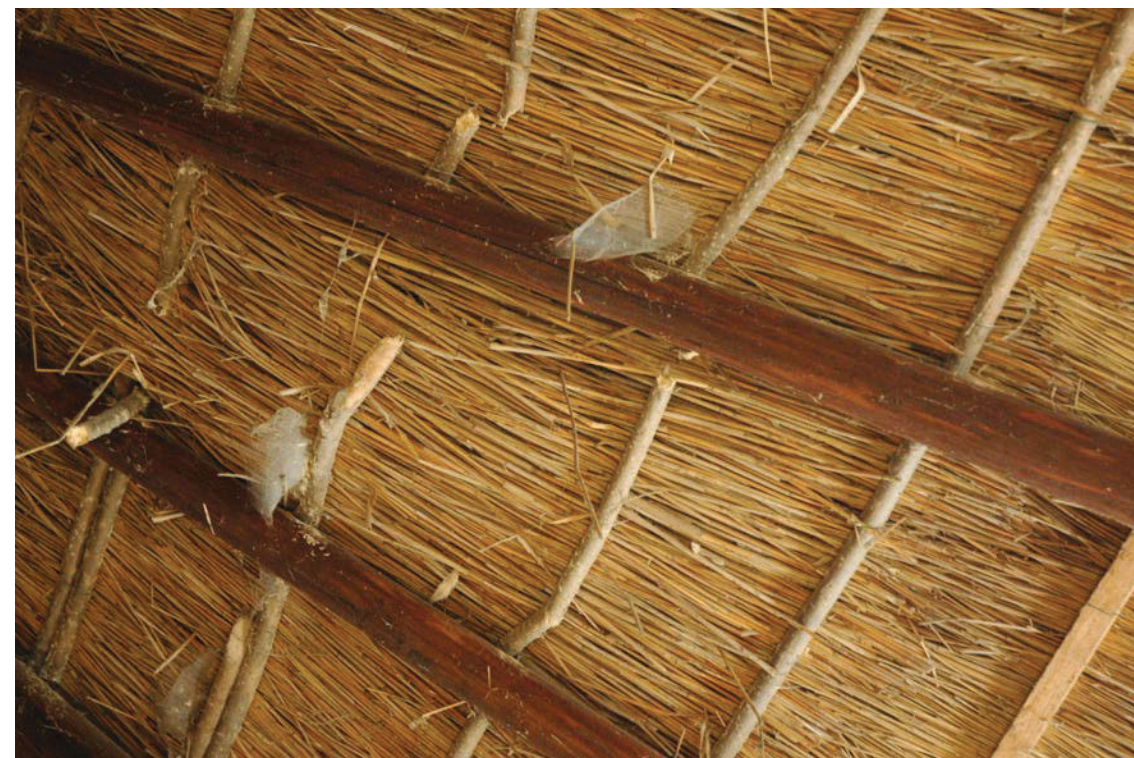
09. Gebroken wilgentenen rietlatten
