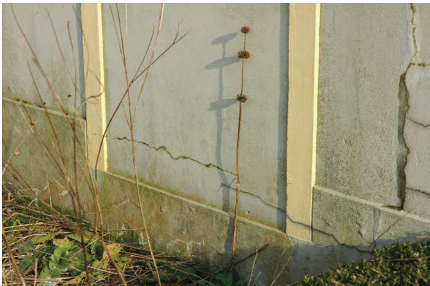
23. Noordwestgevel - scheuren in stucwerk, roestend anker
