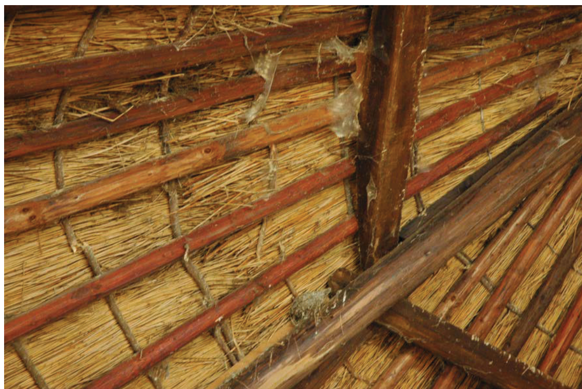
10. Gebroken wilgentenen rietlatten
