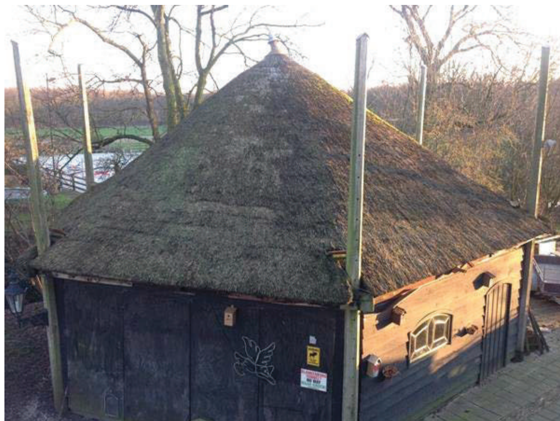
05. Noordzijde dak vanuit dakraam boerderij
