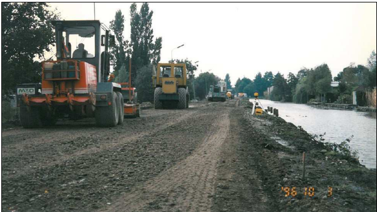
Figuur 2, werkzaamheden aan de Stommeerkade in '96
