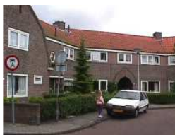
Vervanging van houten kozijnen door kunststof en verwijdering van roedeverdelingen vervlakken het gevelbeeld
