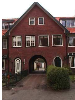
Poortgebouw Maaslaan: Raamprofielen zijn 'sprekender' wanneer zij in een lichte (witte) kleur zijn geschilderd
