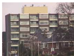
Aandacht voor ontsierende dakopbouwen (installaties, liftopbouwen etc.) is noodzakelijk
