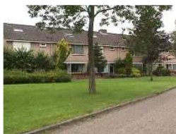
Frans Leharlaan: Strokenbouw en openbaar groen. De daken zijn gedekt met donkere betonpannen. Sobere, eenvoudige gevelindeling. Kenmerkend zijn de rechthoekige erkers (bloemkozijnen)
