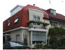
Ongewenste dakkapel op het hoge vlak van een mansardedak
