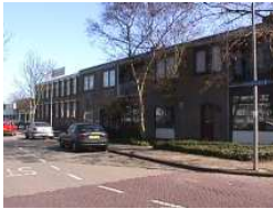
Eenvoudige, utilitaire bedrijfsgebouwen langs de Haven...
