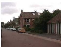
Van Breelaan: complex woningwoningen uit de jaren vijftig. De koppen van de bouwblokken staan haaks op de straat. Gebruik van traditionele materialen.
