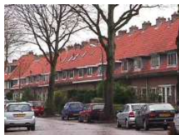
Karakteristiek aaneengesloten rood pannendak met repeterende dakkapellen en schoorstenen in de Rijnlaan
