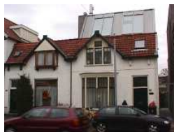
De dakopbouw is te groot. De 'architectonische eenheid' is verbroken
