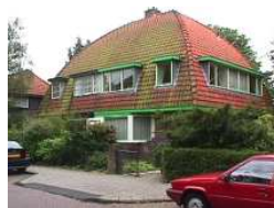
Markante twee onder een forse kapvilla in de Postlaan. Het belgroen geschilderde houtwerk is minder geslaagd.
