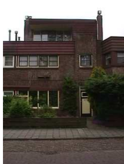
Een dakopbouw die goed past bij de bestaande karakteristiek van het pand in de Postlaan
