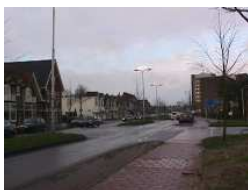
Het brede straatprofiel en de verkeersfunctie bepalen het karakter
