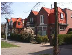
Complexmatige bouw in de Javalaan: aandacht voor kapvormen, architectonische details en traditionele materialen
