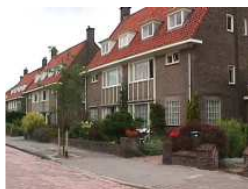
Dubbele woonhuizen, voortuintjes en gemetselde erfafscheidingen in de Alberdinck Thijmalaan
