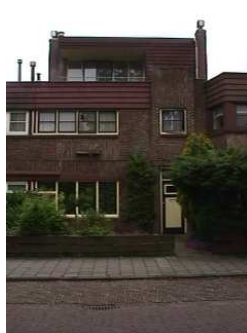
Dakopbouw die goed past bij de bestaande karakteristiek van het pand
