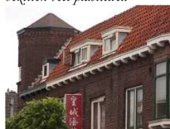
Plasticiteit in de vorm van boekelementen, erkers, gootklossen, dakkapellen
