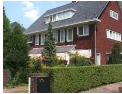
Dakkapel geïntegreerd in het dakvlak
