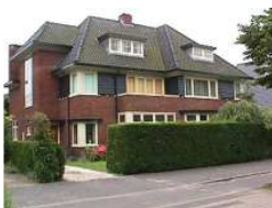
Het 'Heemsteedse type': dubbel woonhuis onder een markante kap, strakke baksteenarchitectuur, grote vensterpartijen en een mooie haag
