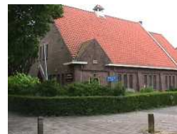
Ambachtelijke bouw, opvallende dakenlaken en een groene erfafscheiding kenmerken dit kerkgebouw in de Postlaan
