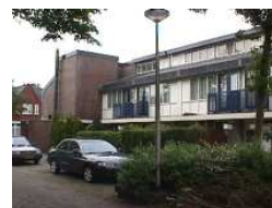
Recente nieuwbouw die opvalt door een van de omgeving afwijkende vormtaal, kleur- en materiaalgebruik.
