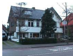
De strakke baksteenarchitectuur is kenmerkend. Gevels behoren daarom ongeschilderd te blijven
