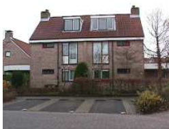
Amer: de architectonische eenheid van de dubbele woning dient behouden te blijven. Dakkapellen moeten dus identiek zijn. Dat geldt ook voor de erfafscheiding
