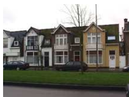
Panden staan in de rooilijn, voorgevels oriënteren zich op de openbare ruimte
