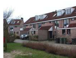
Haringvliet: de bergingen aan de voorgevels vormen een belangrijke karakteristiek. Als bouw materiaal is gebruik gemaakt van baksteen, kunststof en betonpannen
