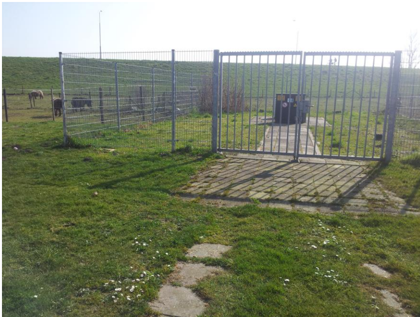
Foto 5. Hekwerk en elektriciteitskast beperken begaanbaarheid van de locatie en verstoren metingen.
