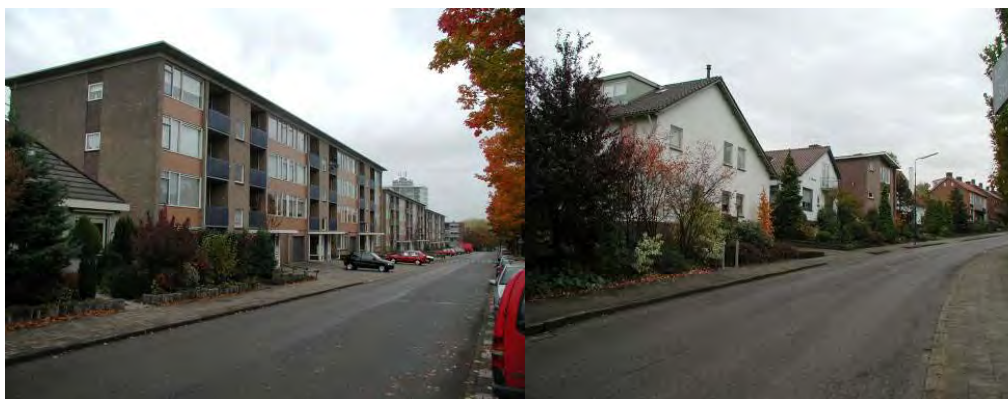
Etagewoningen aan de Papaverstraat.
