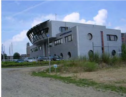
Moderne vormgeving aan de Utrechtsstraatweg.
