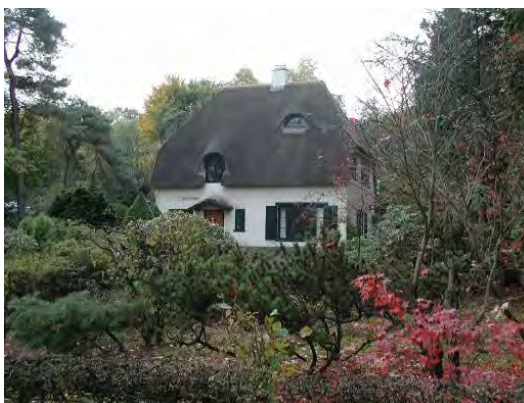
Vooroorlogse villa aan de Bergweg.
