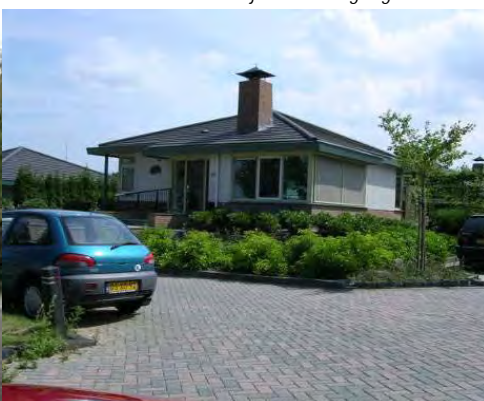
Projectmatige nieuwbouwwoningen aan De Helling.
