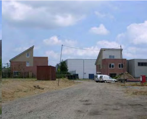
Nieuwbouw bestaande uit bedrijfspanden en bedrijfswoningen.
