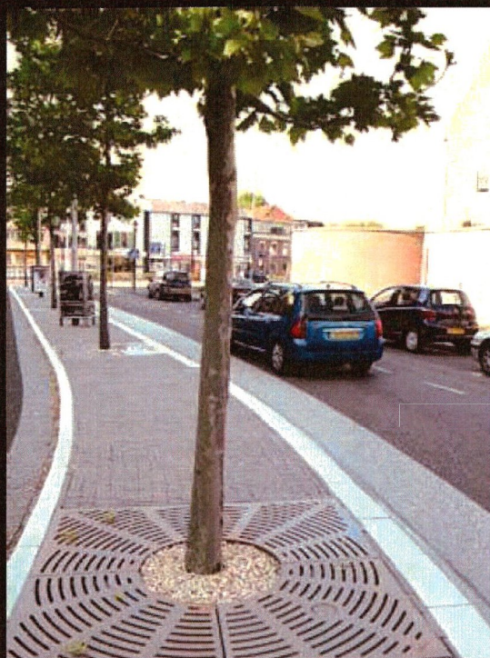
Woerden. BSI Bomengranulaat onder de rijbaan Resultaat 3 jaar na aanplant.
