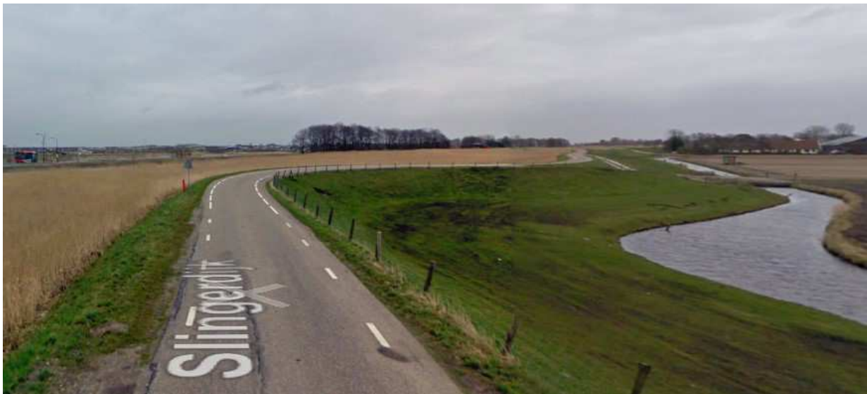
Figuur 5.1: Slingerdijk in sectie 11 met weg op kruin en steil binnentalud (Google)
