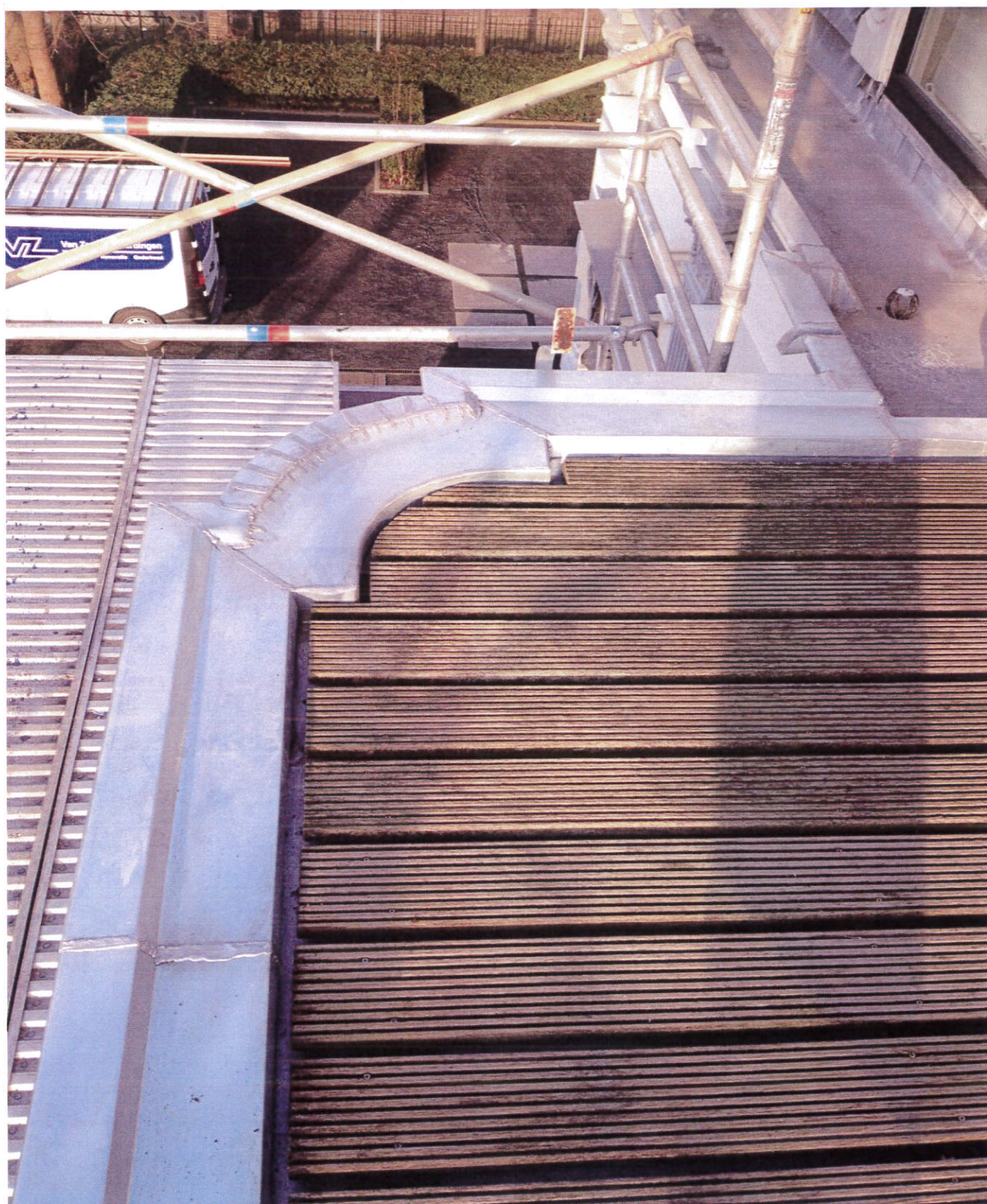
foto 7: nieuw zinkwerk linker deel
