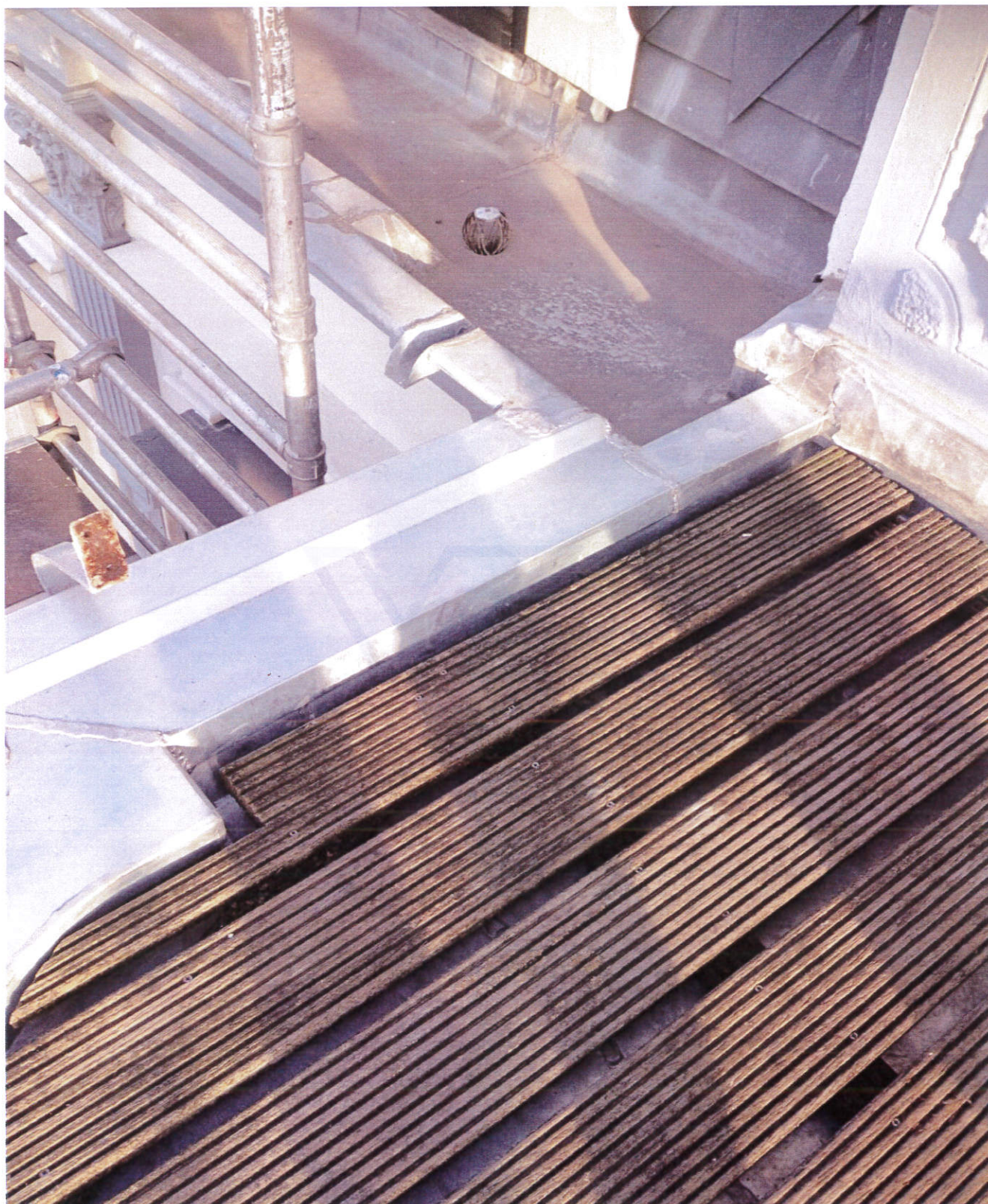
foto 8: nieuw zinkwerk linker deel
