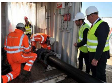
Grondwaterproblemen in Noordwijk aangepakt
