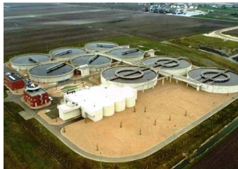
Rijnland innoveert op awzi Zwanenburg met een borstelcentrifuge: het zuiveringsslib wordt ontwaterd zonder toevoeging van hulpstoffen (poly-elektrolyten), met het doel om zowel kosten te besparen als milieuvriendelijker te werken.
