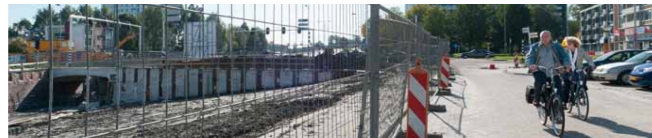
Figuur 3 werk in uitvoering fietstunnel Overijsselseweg (augustus 2010)
