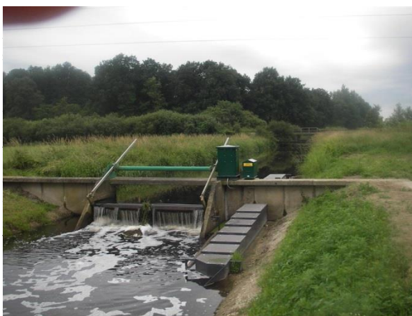
stuw, rechts: verspringende openingen in de vispassage
