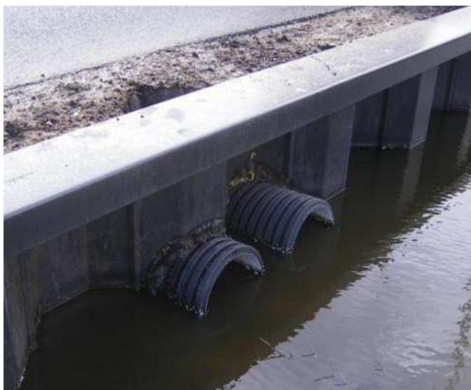
Figuur 2.4: Foto te vervangen duikers 421-033-00372 (bron: Variantenstudie Watergebiedsplan Greenport te Boskoop, Rijnland)
