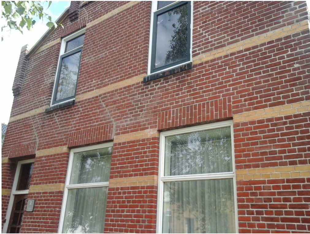
Voorgevel, vervanging bovenramen
