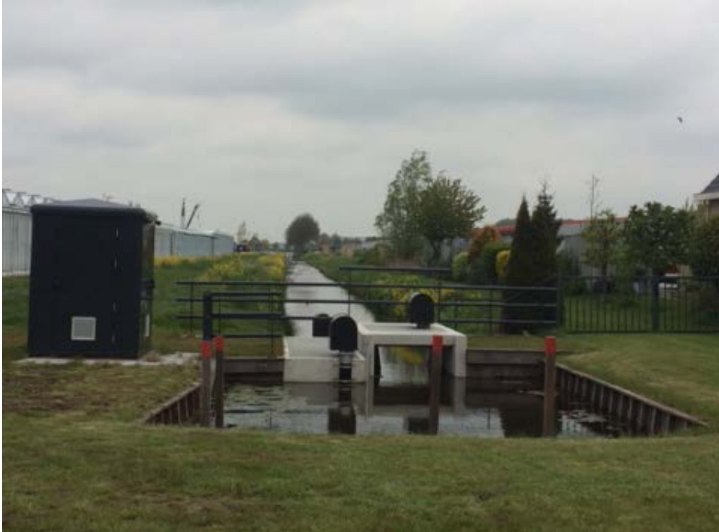
Fig 4. Impressie van klepstuw (bij Spoorwegaan wordt deze uitgevoerd zonder beugelstangen)
