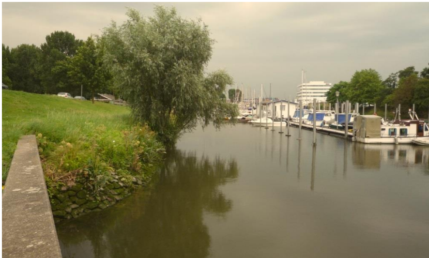
Figuur 6.1 Impressie van de Delflandsedijk ter plaatse van de Spuihaven, met links het buitentalud van de kade en rechts de jachthaven
