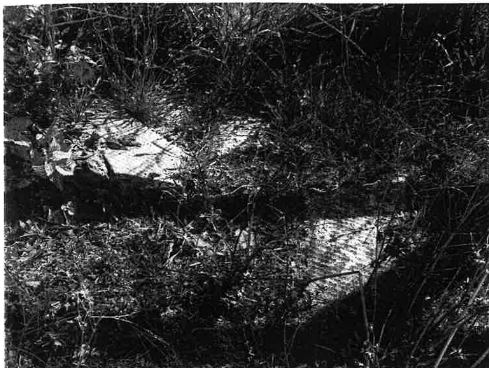
foto 13 Asbesthoudend materiaal op maaiveld
