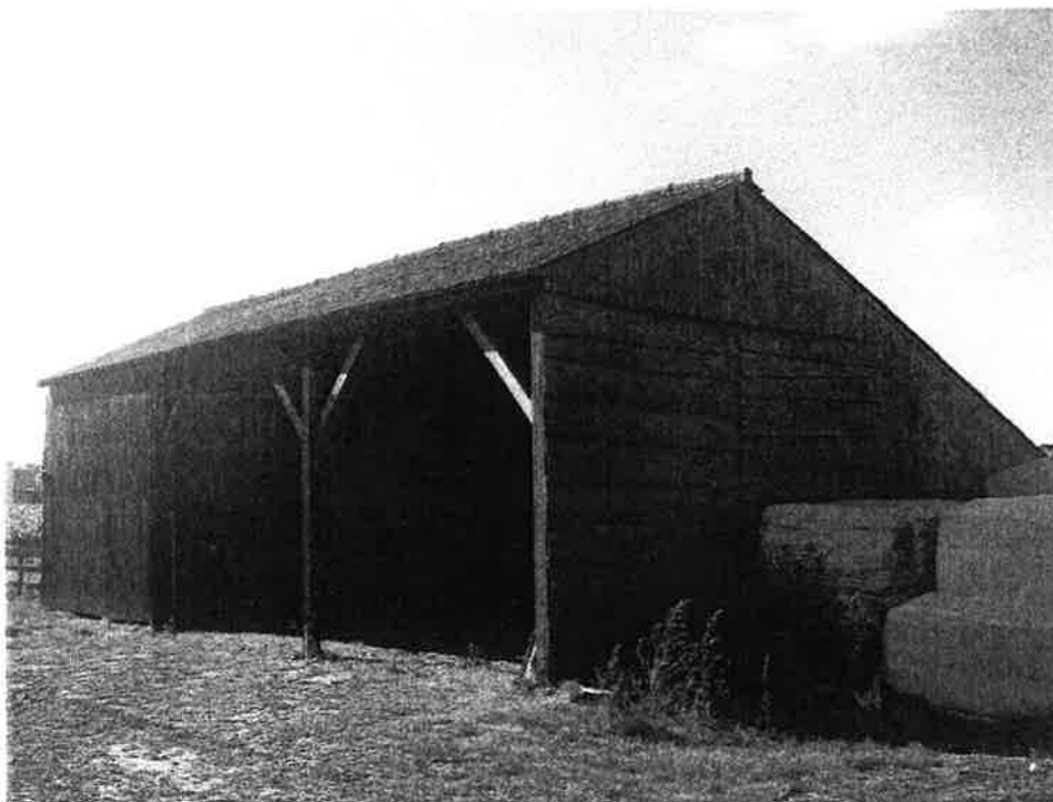
Foto 9 Golfplaten dakbedekking schuur 4; Abm009
