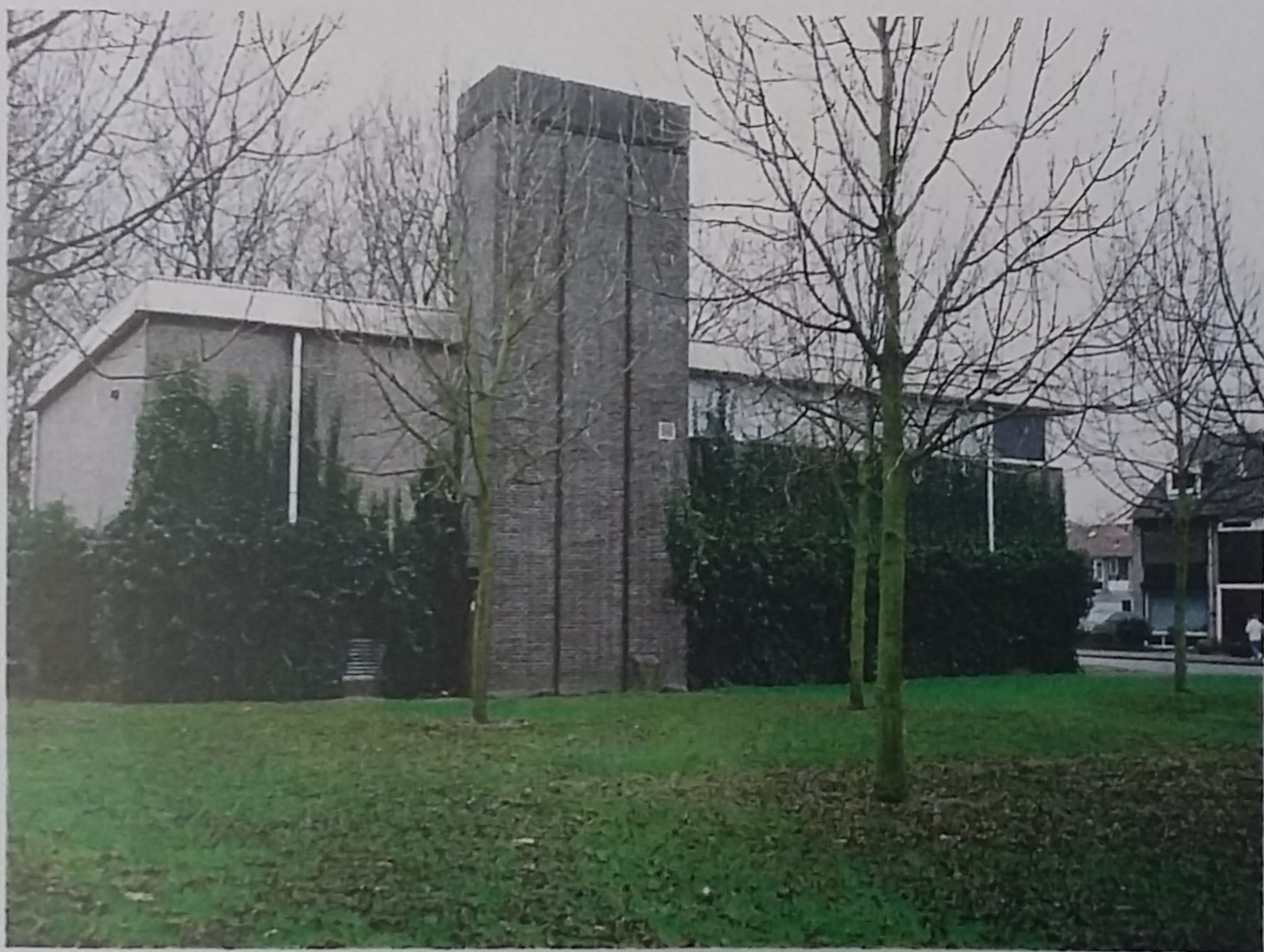
Noordwest-zijde ketelhuis en locatie vml. ondergrondse HBO-tanks
