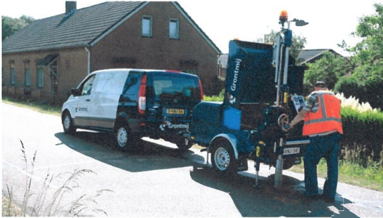
Figuur 3-2 Nader onderzoek wegverharding (boringen)
