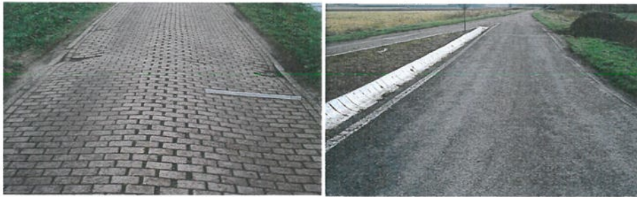
Figuur B-2 Schades dwarssonvlakheid en rafeling
