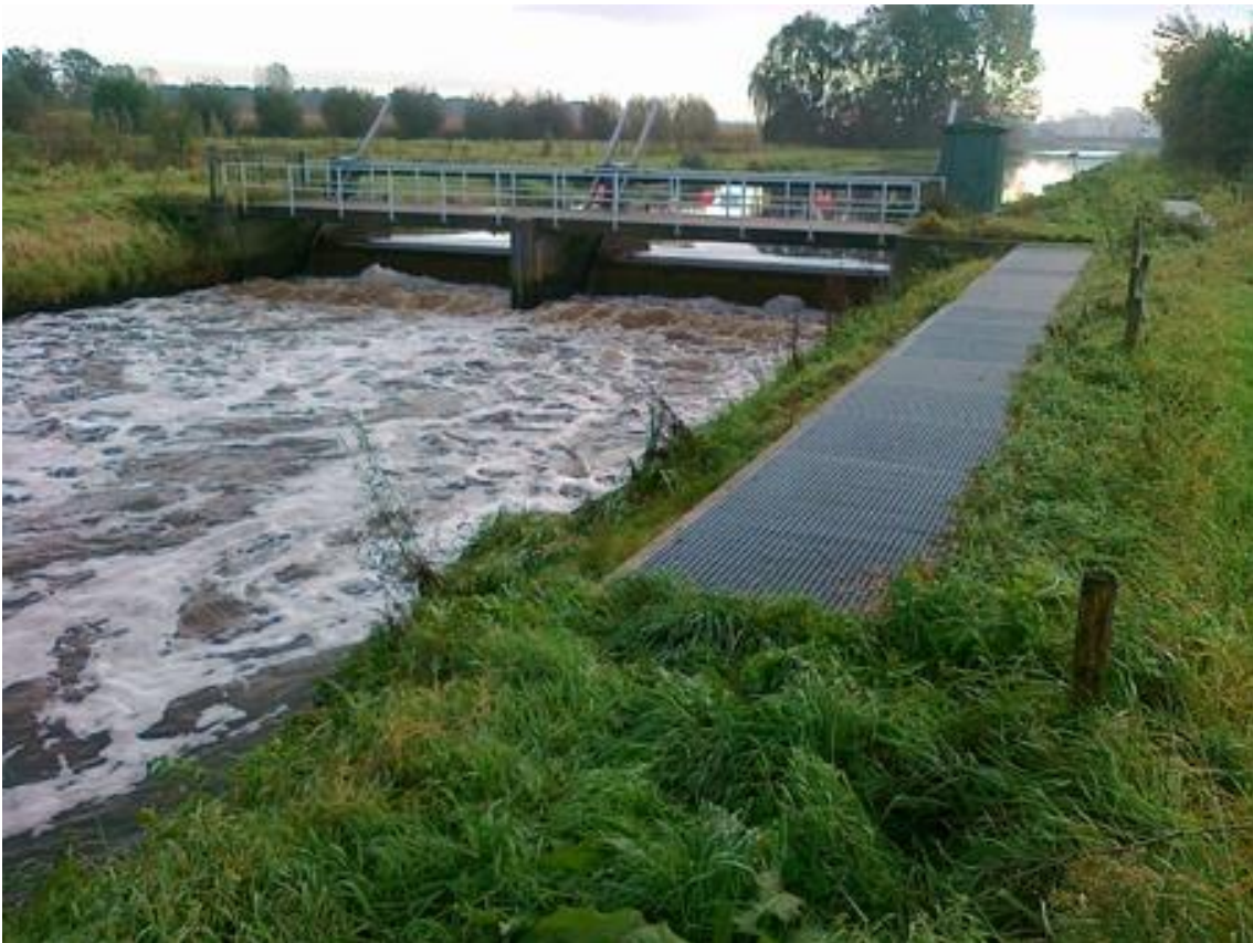
Figuur 8 De Wit vispassage zoals in gebruik bij waterschap Aa en Maas, stuw 201C in de Aa te Veghel
