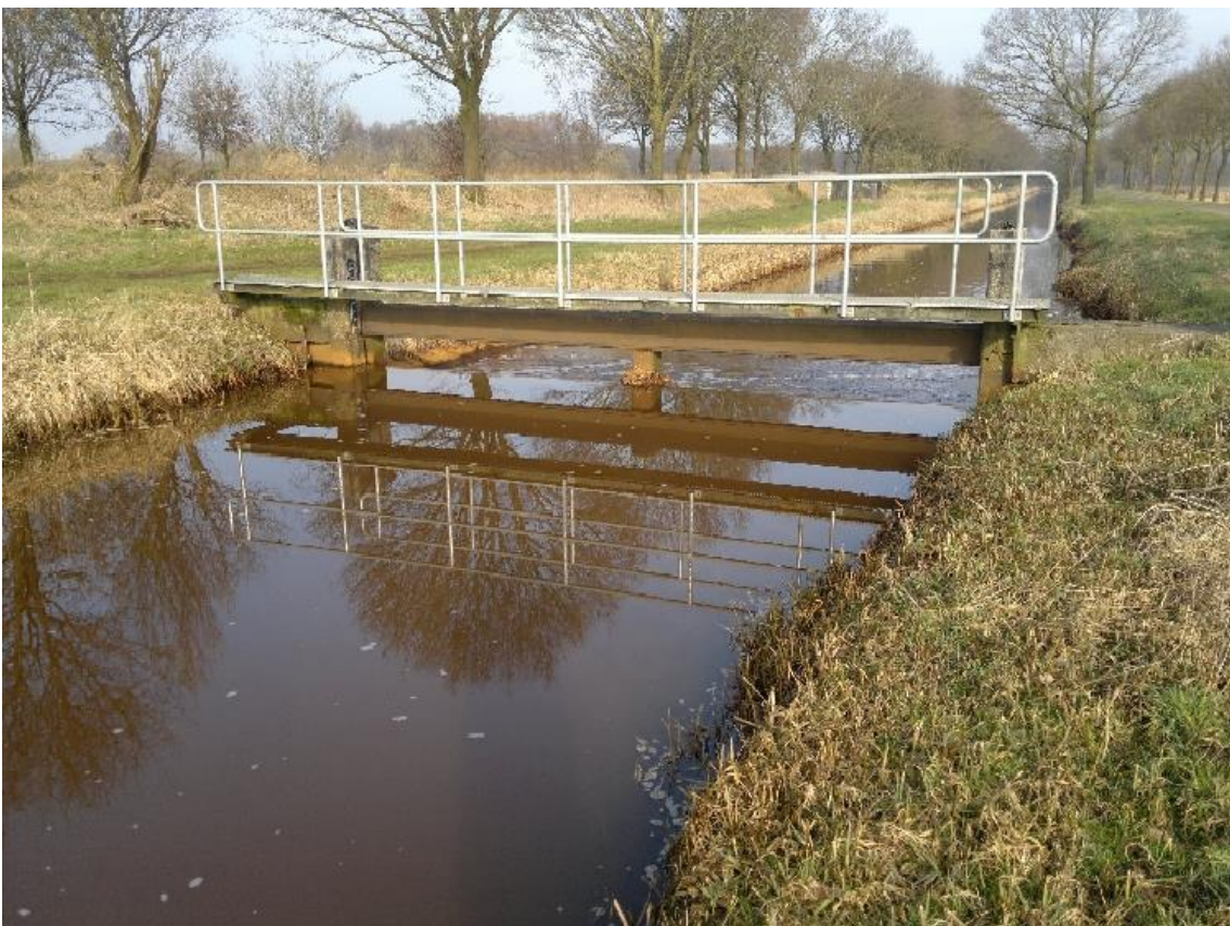
Figuur 9 Stuw 107P02, waar aan de rechterzijde een vispassage gerealiseerd zal worden
