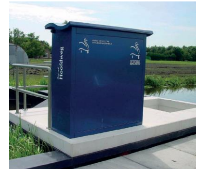
Bij veel stuwen, inlaten en kleine gemalen staan deze blauwe bedieningskastjes met 'golfdak'.
