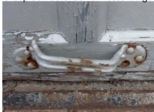
Greep aan de onderkant beschadigd
