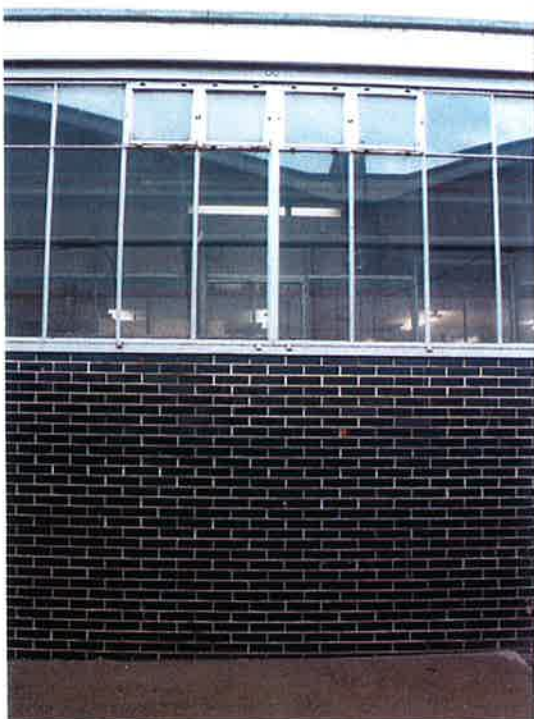
afb. 16. De achtergevel maakte vroeger deel uit van de terreinmuur –de terreinmuur is gesloopt, verder is de gevel ongewijzigd. (foto DEK 0041-4)
