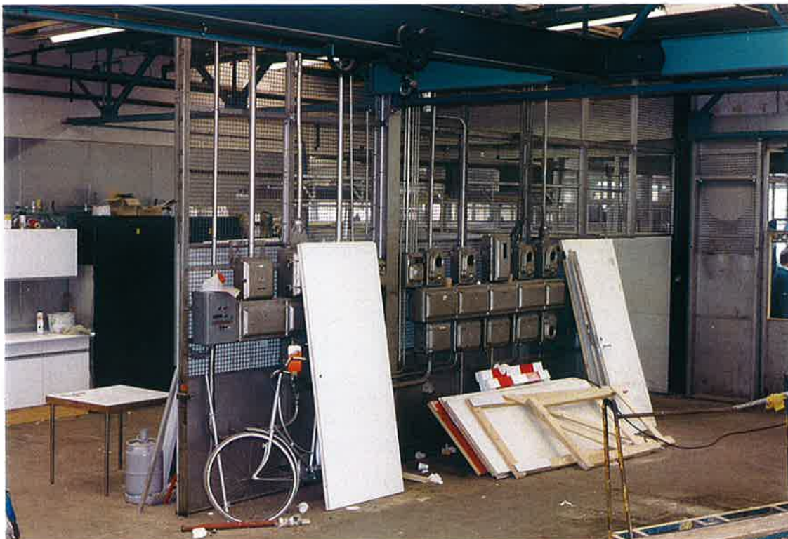
afb. 25 Restant van de binnenpui rond het oorspronkelijke gereedschappenmagazijn (ruimte 10, tegen ruimte 25 aan): een standaard borstwering met daarboven gaashek – de balie erachter is verwijderd. Of de elektrische installaties zich altijd op deze plek bevonden hebben is niet bekend. (foto 27.03.02- 17)
