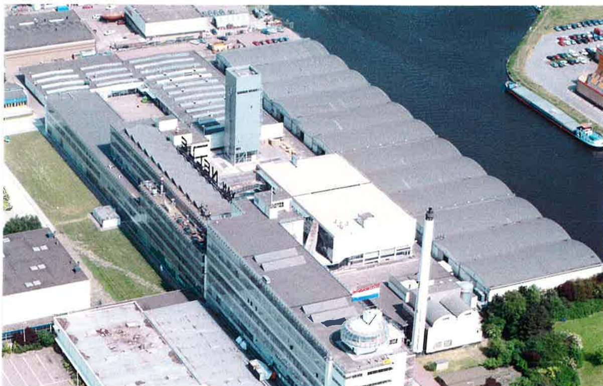
afb. 8. Op deze luchtfoto uit 1992 zijn ook de laatste oorspronkelijke lichtstraten verdwenen en het deel van Bedrijven dat ooit de timmermanswerkplaats huisvestte, ten zuiden van de brandmuur, is geweken voor de gloednieuwe koffiesilo. (VNHA, KLM KO 26768)
