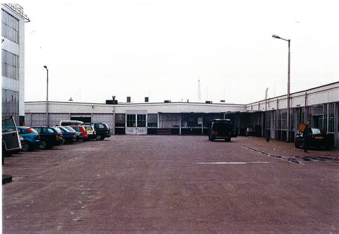
afb. 18. De gevel van de korte poot in de Huidige Toestand: de overheaddeuren zijn voor de helft vervangen door een gesloten borstwering met een stalen glaspui erboven, in de binnenhoek is een kleine uitbouw gemaakt en boven de glaspuien is een lamellenluifel toegevoegd. (foto 27.03.02-36)
