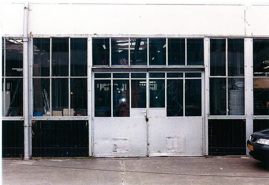
Gevel HT maart 2002 – as D travee 40-41: de oorspronkelijke deuren draaiden naar buiten – erachter bevond zich in de OT de lakkamer. De deuren zijn niet alleen vervangen door minder hoge, naar binnen draaiende deuren maar ze zijn (waarschijnlijk) ook breder dan de oude deuren. (foto 27.03.02 - 22)
