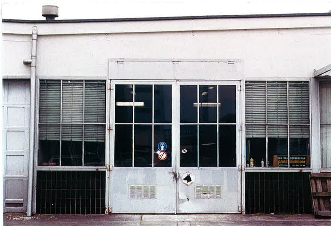
Gevel HT maart 2002 – as 46 travee EF: i.p.v. twee overheaddeuren zijn dubbele, naar buiten draaiende deuren gekomen met aan weerszijden een glaspui op gemetselde, betegelde borstwering. De deuren zijn breder dan die in gevel van de 'lange poot'. Achter een stalen klep bevindt zich een filter voor de afzuiging van de lucht in de spuitcabine die zich nu erachter bevindt. (foto 27.03.02 - 28)
