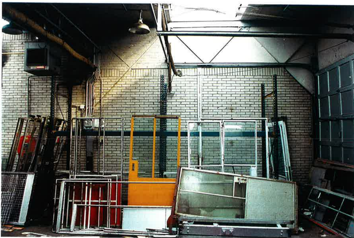
afb. 12. portaalconstructie Huidige Toestand, authentieke overheaddeur en geleidingsmechanisme, authentieke lichtarmaturen, toegevoegde metselwerk binnenwand (foto DEK 0041-31)
