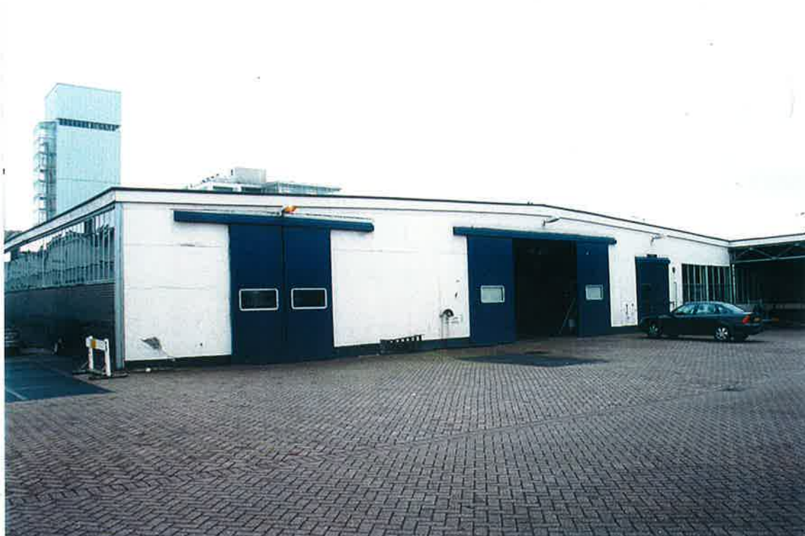
Achtergevel HT maart 2002 – as 50 travee A-B-C-D: van de vier stellen oorspronkelijke draaideuren zijn er twee vervangen door schuifdeuren, de grote schuifdeur in het midden is veel groter dan de oorspronkelijke deuropening. Een oorspronkelijke deuropening is dichtgezet en de vierde is vervangen door een stel draaideuren met een loopdeur er in. (foto DEK 0041 - 18)
