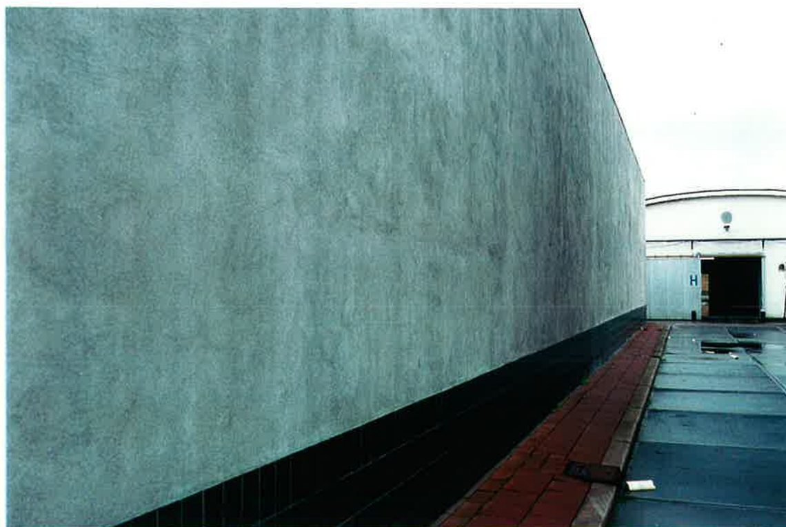
Gevel HT maart 2002 – as 36: de oorspronkelijke brandmuur is, na sloop van traveeën 33-34-35-36, buitenmuur geworden. De grijze tegellambrisering is verwijderd, de deuropening dichtgezet en de plint voorzien van een ca. 0.80 m hoge strook matzwart, “imitatie-Delftsch” tegelwerk. (foto DEK 0041 - 3)
