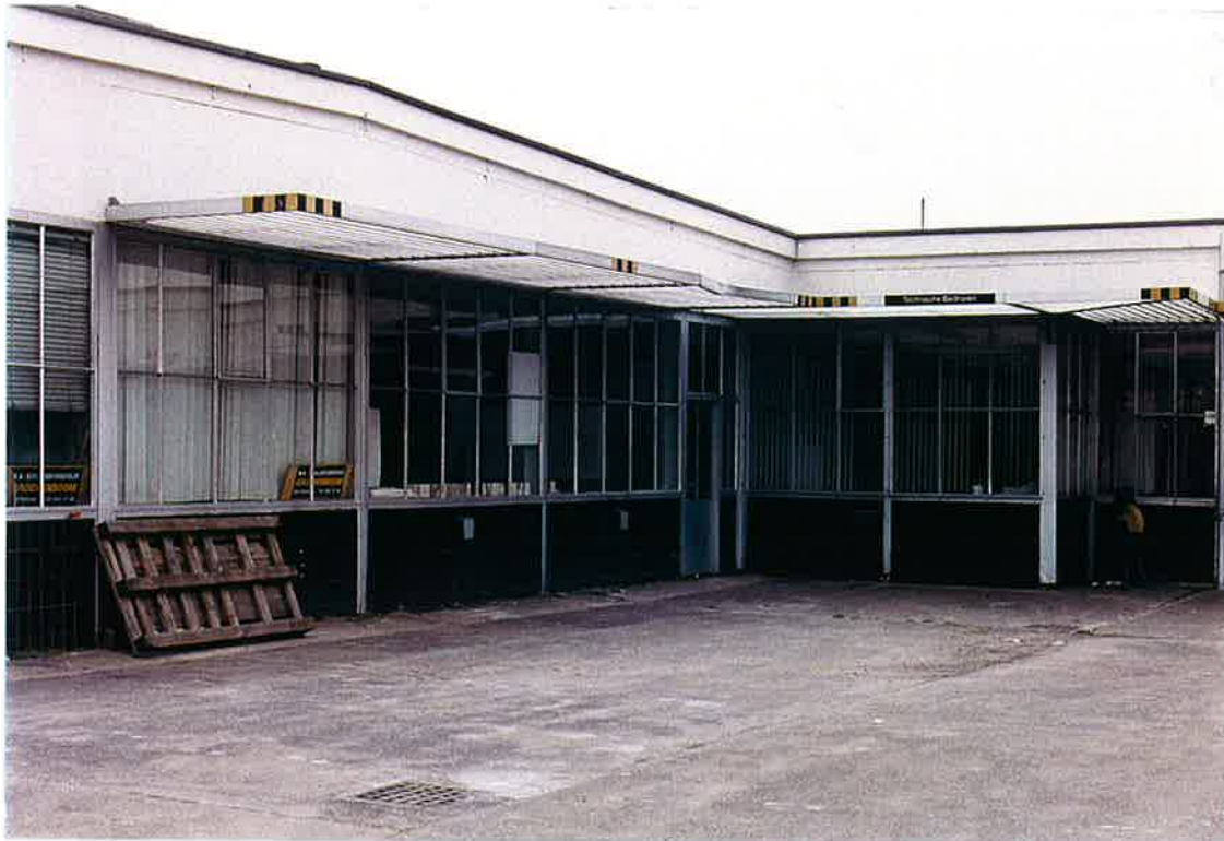
Gevel HT maart 2002 – as 46 travee D-E: in de binnenhoek is een uitbouw gemaakt, de gehele hoek is van een lamellenluifel voorzien en de overheaddeuren zijn vervangen door glaspuien boven gemetselde borstweringen. Deze zijn grotendeels betegeld met oorspronkelijke "Delftsche" tegels. (foto 27.03.02-27)
