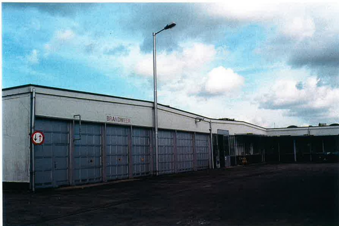
Gevel HT maart 2002 – as 46 travee D-E-F-G-H: de helft van de oorspronkelijke overheaddeuren zijn gespaard gebleven, één is echter voorzien van een loopdeur. De overige overheaddeuren zijn vervangen door een gevel met een gemetselde, zwart betegelde borstwering. (foto DEK 0041 - 34)
