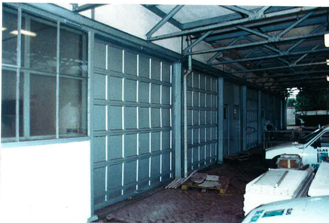
Gevel HT maart 2002 – as 50 travee E-F-G-H: van de oorspronkelijke overheaddeuren zijn er twee vervangen door een staalplaat met loopdeuren erin, het oorspronkelijke mechaniek van de verwijderde overheaddeuren is echter bewaard gebleven. (foto DEK 0041 - 13)
