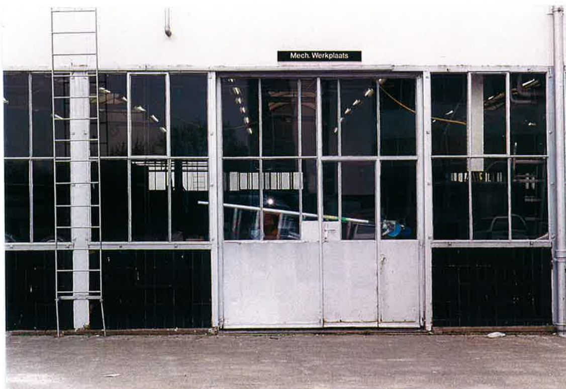
Gevel HT maart 2002 – as D travee 42-43: de oorspronkelijke draaideuren zijn voorzien van een loopdeur, voor het overige is de gevel in deze travee gelijk aan de OT. (foto 27.03.02 - 24)
