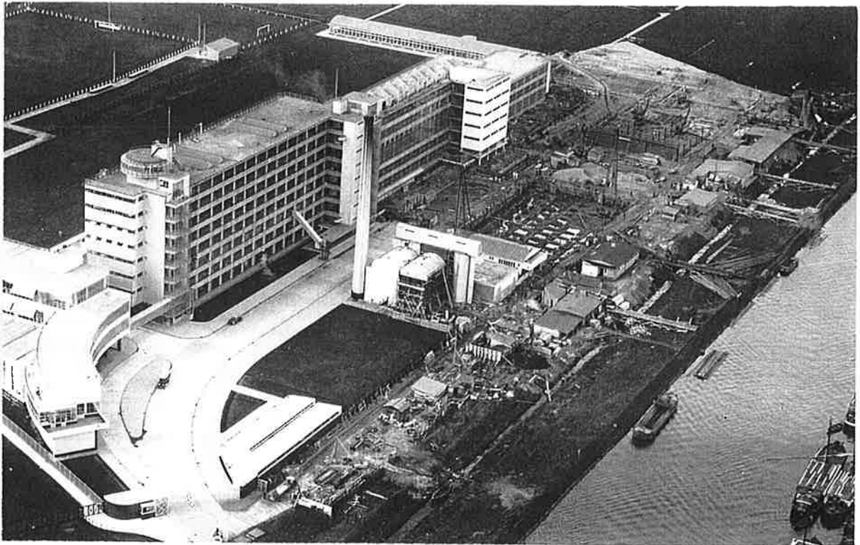
afb. 3. Foto september 1929 waarop te zien is hoe de staalconstructie aan de zuidkant al deels is opgericht terwijl het heilwerk voor de fundering verderop nog in uitvoering is. (VNHA, KLM 9148)
