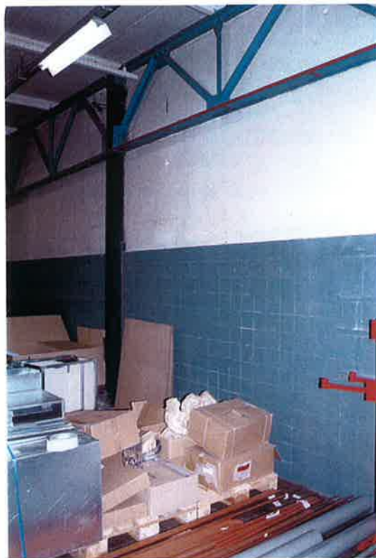
afb. 17. Het oorspronkelijke lambris van grijze tegels op de binnenzijde van gesloten gevels is grotendeels intact. (foto DEK 0041-2)
