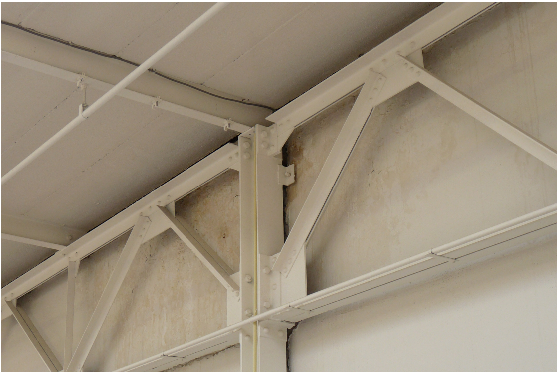
spantconstructie t.p.v. kopgevel bouwdeel A
