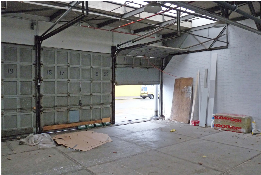
huidige toestand overheaddeuren. In maximaal opgetrokken toestand ligt de deur horizontaal, recht onder het daklicht
