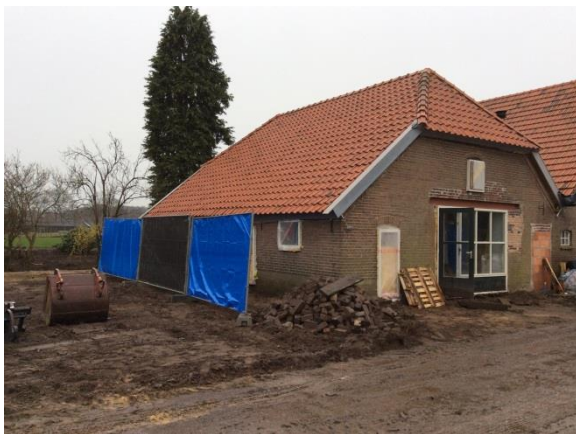
Figuur 8: Overzichtsfoto bebouwing
