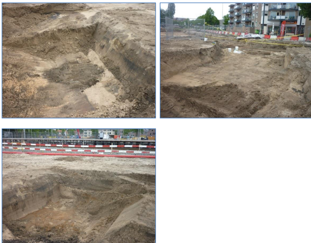
Foto's 3.9 t/m 3.11: ontgravingsput sanering met asbest verontreinigde grond
