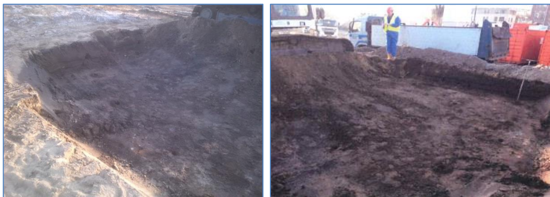
Foto's 3.1 en 3.2: Ontgravingsput
