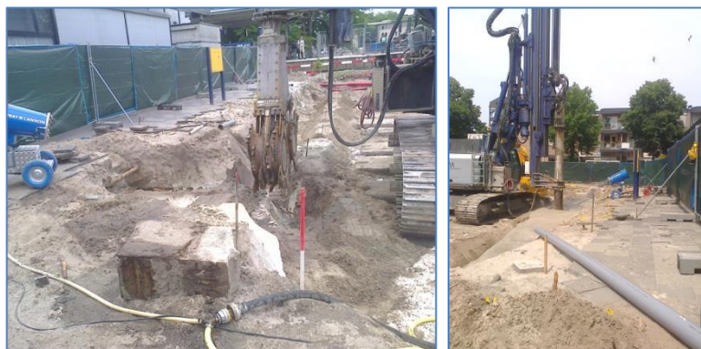
Foto's 3.14 en 3.15: aanbrengen grondkerende wandconstructie met 'soilcutter'.
