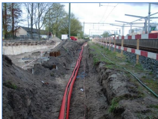
Foto's 3.3 t/m 3.5: verleggen kabels en leidingen
