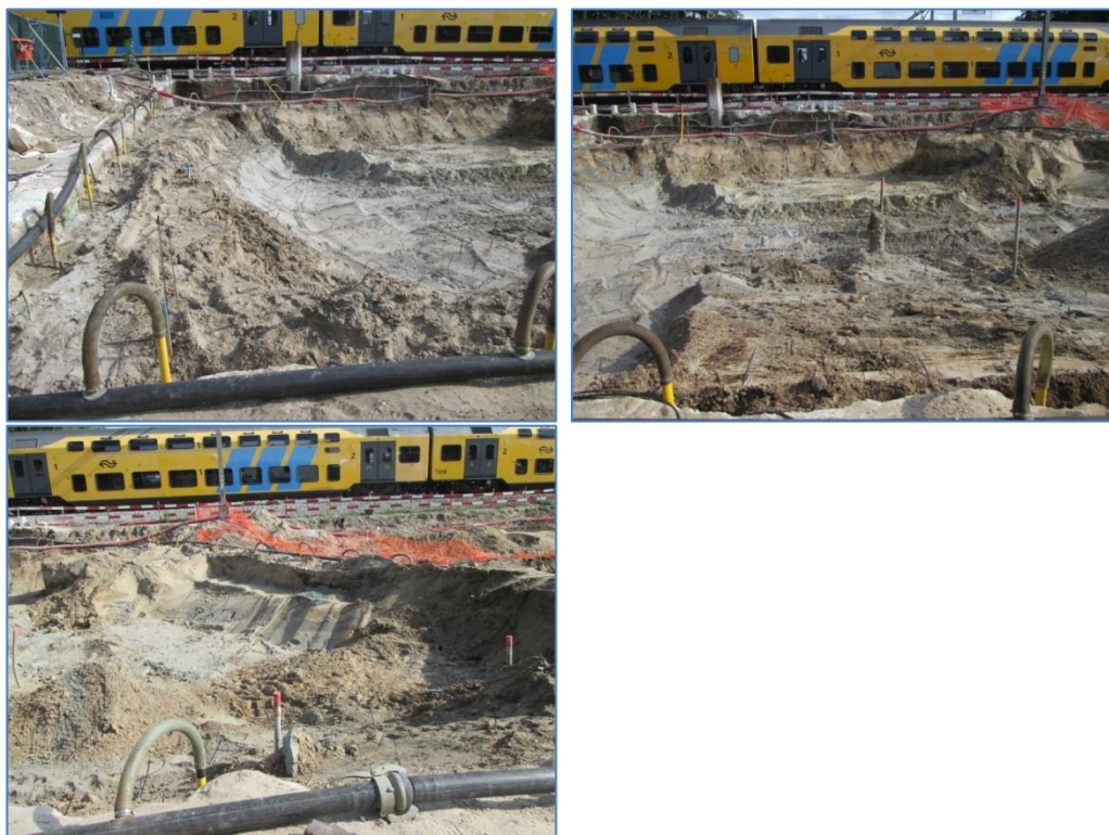
Foto's 3.18 t/m 3.24: ontgravingswerkzaamheden 17 juli 2015.
