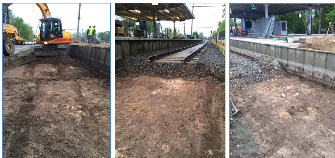
Foto's 3.6 t/m 3.8: ontgravingswerkzaamheden.
