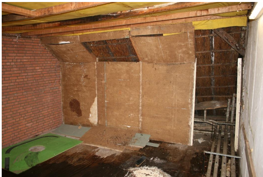
Overzicht van de verdieping boven de bijkeuken en berging met rechts de brandmuur. De ruimte werd in de jaren '80 van de twintigste eeuw gedeeltelijk afgetimmerd.
