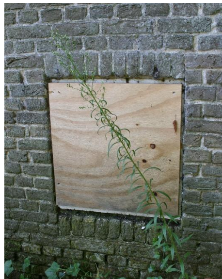
Op de linker afbeelding één van de twee linker keldervensters. Op de rechter afbeelding het rechter keldervenster. De twee linker vensters zijn aan de onderzijde voorzien van een hardsteen onderdorpel. De drie vensters komen alle aan één zijde uit met het kruisverband van de gevel. Aan de andere zijde zijn onregelmatigheden in het metselwerk aanwezig, waarbij de gezaagde kant van de koppen zich niet aan de dagkant bevindt. Vermoedelijk waren deze vensters reeds aanwezig in de kelder toen de gevel gemetseld werd.
