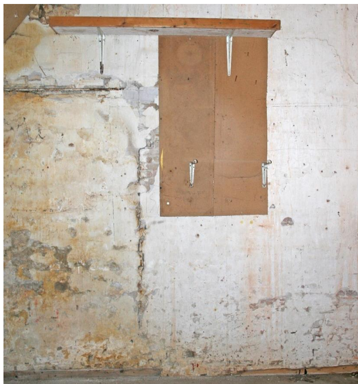
Zicht op de bouwnaad tussen de linker zijgevel van de stal links en de voorgevel en aansluitend de brandmuur van het voorhuis rechts. De linker zijgevel van de stal werd plaatselijk ingekast in het reeds bestaande metselwerk van het voorhuis.
