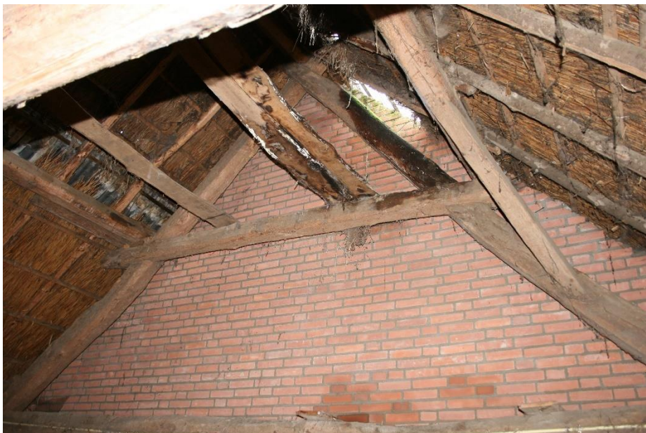
Zicht op het in eiken uitgevoerde schaarspant nabij de scheidingsmuur in de stal.
