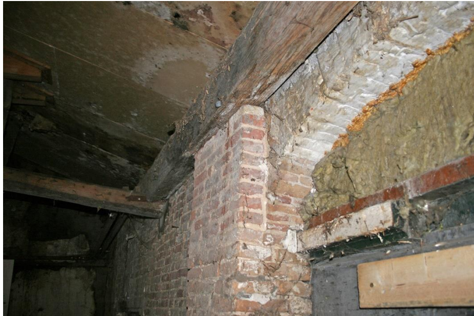
Detail van de aansluiting van de muurdam op de korfboog boven de deel deur, waar de voorgevel plaatselijk twee steens dik is. Het bovenste deel van de muurdam is secundair ten opzichte van de boog.
