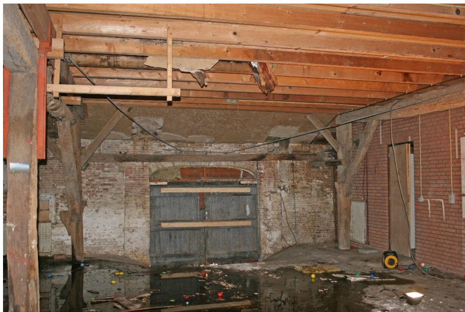
Zicht op de gebinten in het achterste deel van de stalruimte, gezien richting de voorgevel. In het midden is onder de tussenbalk een stijl geplaatst. Het hoogteverschil van circa 60 cm tussen het oorspronkelijke vloerniveau en de secundaire betonvloer (XXd) is zichtbaar nabij de deeldeuren.
