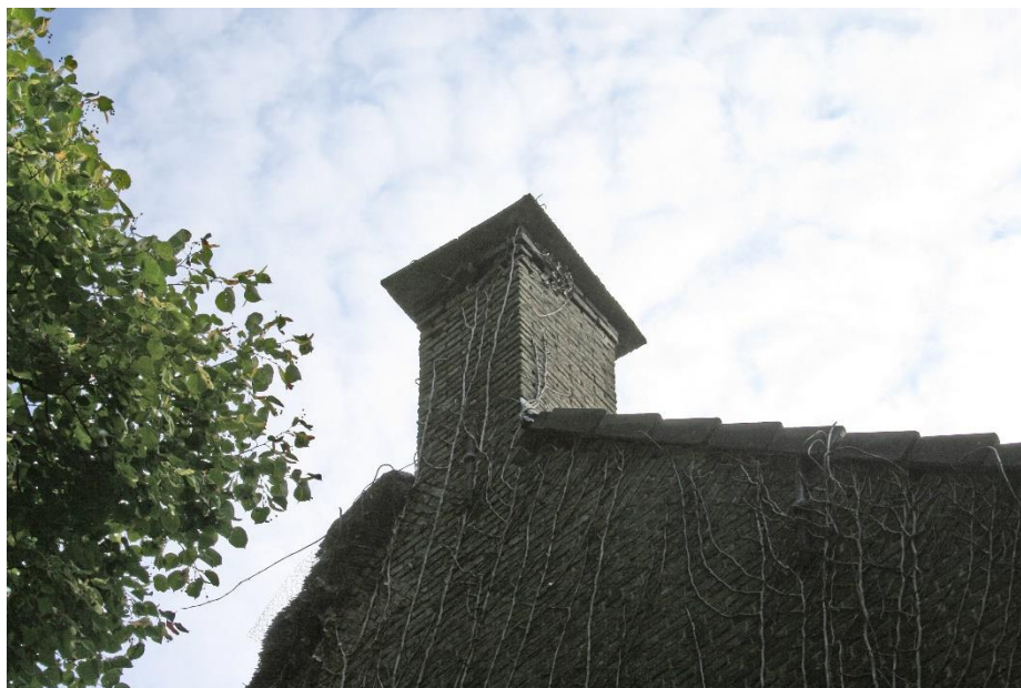
Zicht op de geveltop met daarop de gemetselde schoorsteen.
