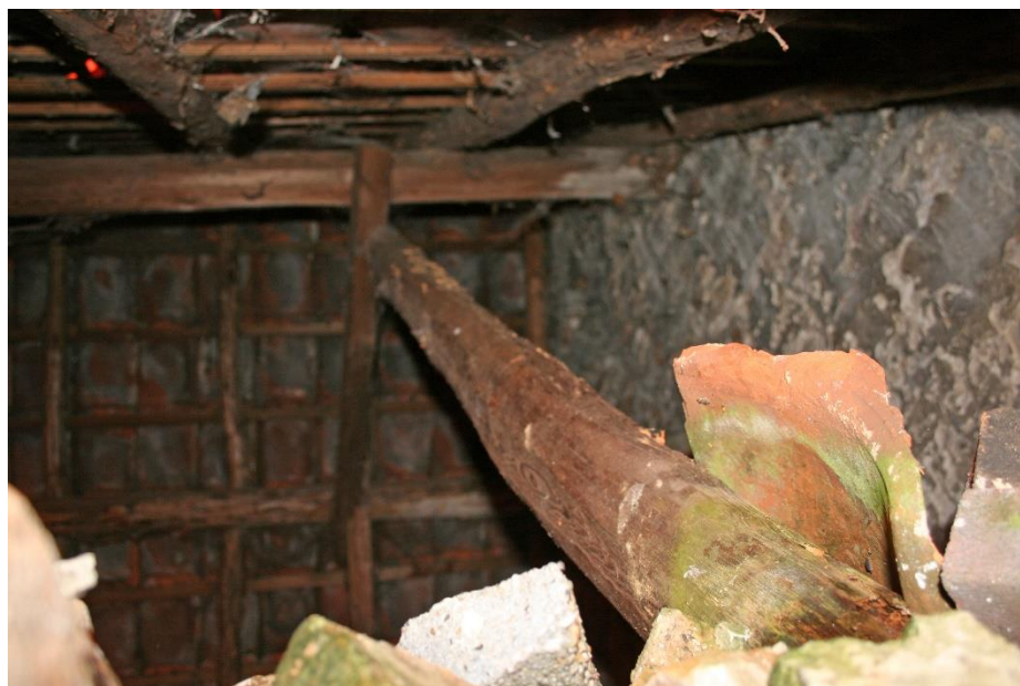
Zicht op de kapconstructie van het bakhuisje.
