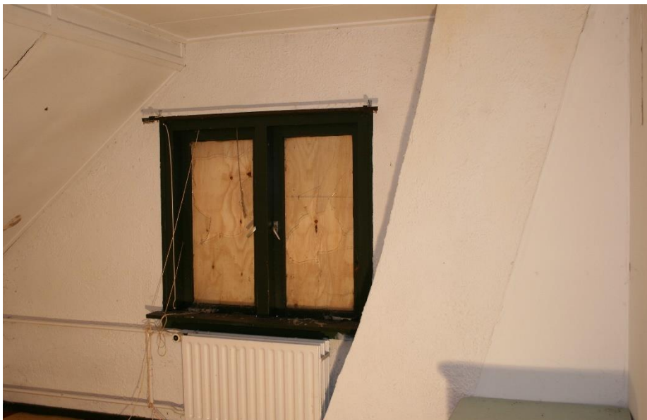
Overzicht van de slaapkamer boven de linker voorkamer. De beide zolderkamers kennen eenzelfde afwerking. Rechts van het in 1958 vergrote venster wordt het rookkanaal van de onderliggende haard verslept naar de schoorsteen in het midden van de topgevel.
