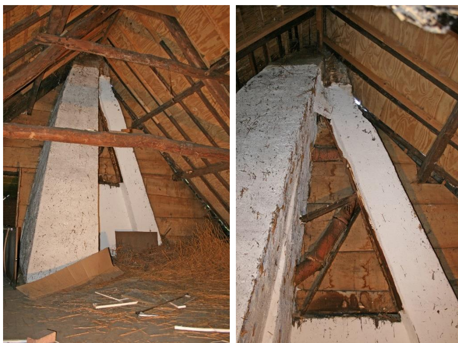
Op de linker afbeelding zicht op de brandmuur tussen het voorhuis en de stal. De wand is ter hoogte van de verdieping bekleed met zeer brede delen die het achterliggende spant aan het zicht onttrekken. Op de rechter afbeelding de aansluiting van de beide rookkanalen op de schoorsteen op de nok. Het linker rookkanaal behoort bij de rookvang in de keuken, het rechter kanaal bij de haard in de rechter voorkamer.
