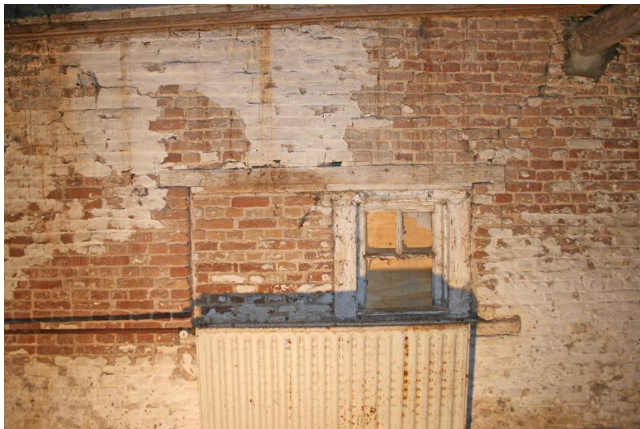
Zicht op het venster links van de deel deuren aan de binnenzijde van de voorgevel. Ook dit venster is opgenomen binnen een grotere rechthoekige inkassing, met aan de boven- en onderzijde een houten latei. Het verband van de binnenzijde van de gevel is onregelmatig in tegenstelling tot het kruisverband aan de buitenzijde van de gevel.
