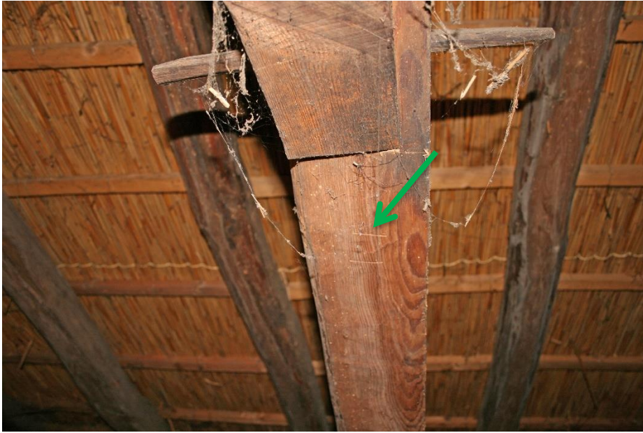
Zicht op de binnenzijde van de eiken krommer van het tweede spant met daarin het telmerk (groene pijl).
