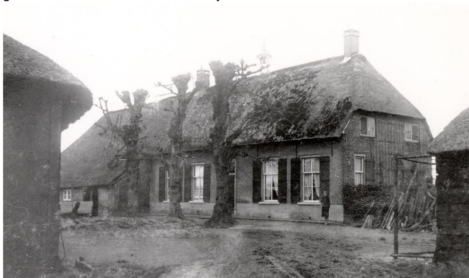
Zicht op het voorhuis van de hoeve Schoondonk, voor de brand tussen 1950 en 1959. De hoeve werd gedateerd als gebouwd in 1650. Bron: Stadsarchief Breda, nr. 19930384.
