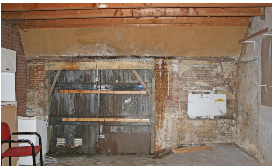
Overzicht van de berging direct achter de brandmuur, gezien richting de voorgevel. Rechts de brandmuur, links de scheidingswand uit de jaren '80 van de twintigste eeuw. De betonvloer loopt schuin af richting de deeldeuren in de voorgevel.
