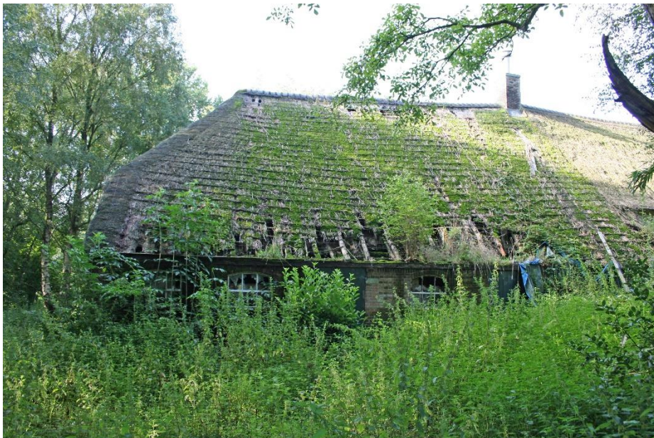
Overzicht van de achtergevel van het stalgedeelte in de huidige situatie.
