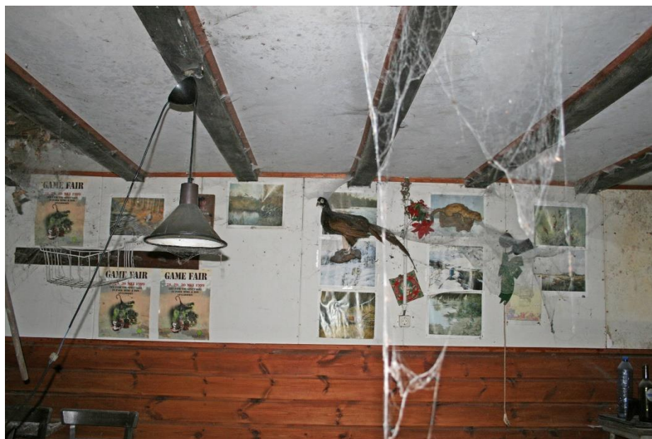
Zicht op de balklaag ter hoogte van de daklijn.
