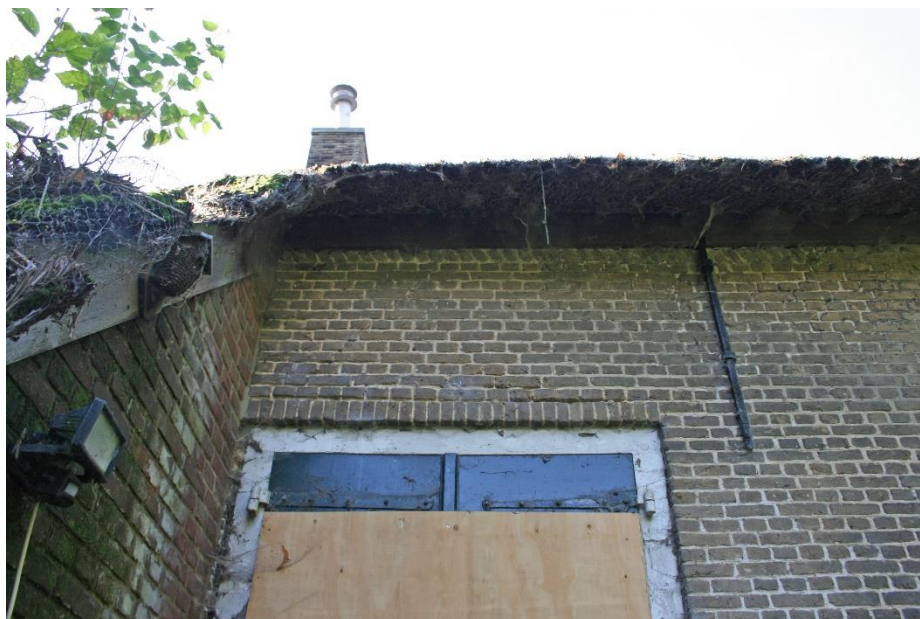
Zicht op het metselwerk boven het keukenvenster geheel links in de achtergevel van het voorhuis. Juist onder de muurplaat bevindt zich boven het venster een stroomlaag in het metselwerk. In het rechter deel van de gevel loopt het kruisverband tot onder de muurplaat door. De schieter van het anker is door twee stroppen van achterliggende veren geschoven, behorende bij de balklaag van de verdiepingsvloer en de blokeels van de kaspanten.
