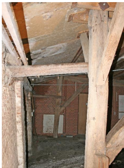
Op de linker afbeelding zicht op de gebintstijlen nabij de voorgevel van de stal. De verbinding van de stijlen naar de wijkende voorgevel werd waarschijnlijk in de jaren '80 van de twintigste eeuw aangepast. Op de rechter afbeelding zicht op de verbinding tussen de tussenbalk en de gebintstijl van het gebint nabij de secundaire scheidsmuur (XXd).
