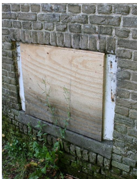
Op de linker afbeelding één van de twee linker keldervensters. Op de rechter afbeelding het rechter keldervenster. De twee linker vensters zijn aan de onderzijde voorzien van een hardsteen onderdorpel. De drie vensters komen alle aan één zijde uit met het kruisverband van de gevel. Aan de andere zijde zijn onregelmatigheden in het metselwerk aanwezig, waarbij de gezaagde kant van de koppen zich niet aan de dagkant bevindt. Vermoedelijk waren deze vensters reeds aanwezig in de kelder toen de gevel gemetseld werd.
