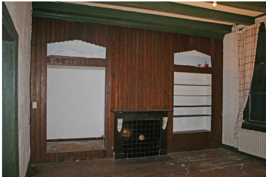
Zicht op de oostelijke wand van de rechter voorkamer. De kastenwand behoort waarschijnlijk tot de midden negentiende opzet van het voorhuis, maar de huidige bekleding (XXB) en haard (XIXd/XXa?) zijn van recenter datum.
