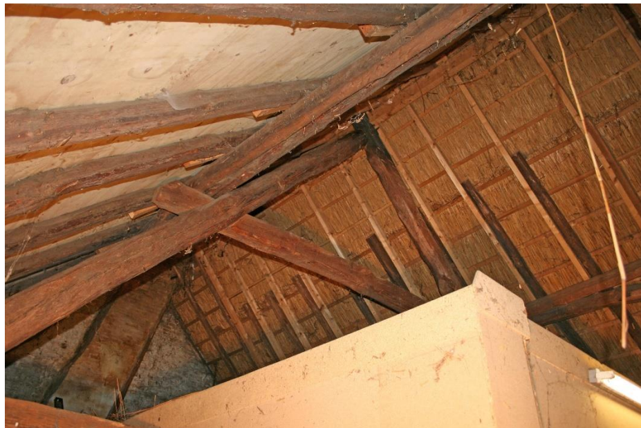
Zicht op het schaarspant boven het afgetimmerde deel van de verdieping.
