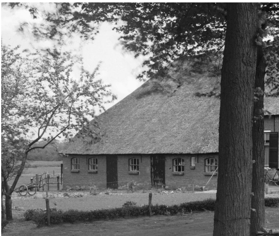
Zicht op de achtergevel van het stalgedeelte in 1962. Afbeelding door G.J. Drukker, mei 1962. Bron: Beeldbank Rijksdienst voor het Cultureel Erfgoed, nr. 73.732
