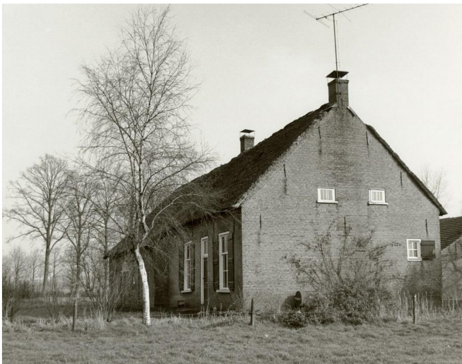
Zicht op de kopgevel van het voorhuis van Galderseweg 79. Bron: Stadsarchief Breda, nr. 19750022.
