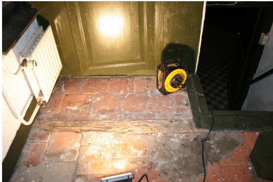
Zicht op de vloer van de overloop van de opkamer. Tussen de estrikken tekent zich de houten balk af waarop de trap naar de opkamer is opgelegd. De paneeldeur (XIXb/m) aan de bovenzijde van de afbeelding geeft toegang tot een vaste kast boven de keldertrap.
