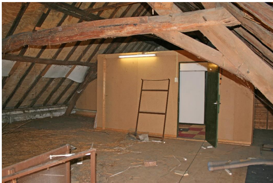
Overzicht van de open zolder boven het voorhuis gezien richting de linker zijgevel en de afgetimmerde slaapkamers.
