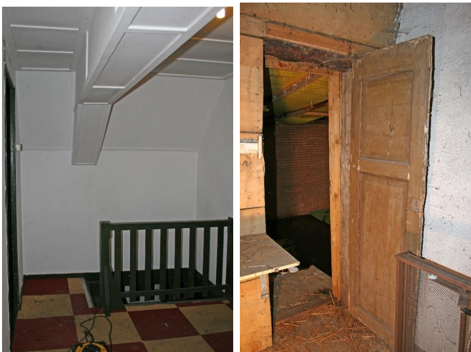
Op de linker afbeelding het overzicht van de overloop, gezien richting de achtergevel met de trapgang en het afgetimmerde dekbalklук. Op de rechter afbeelding de op zijn kop opgehangen paneeldeur (XIXb/m) in de brandmuur tussen het voorhuis en de stal.
