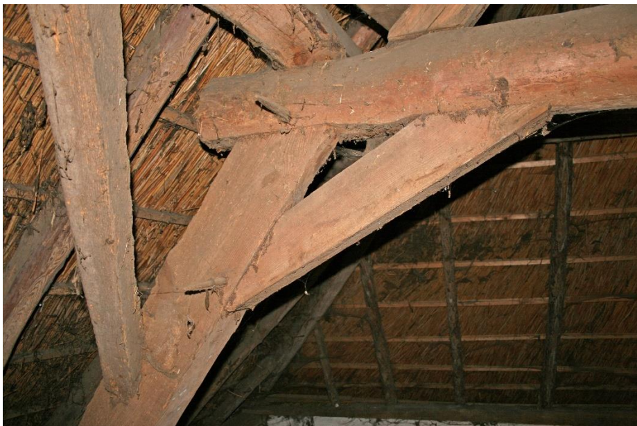
Zicht op de verbindingen van het grenen jukbeen van het dekbalkjuk nabij de rechter zijgevel. Waarschijnlijk dateert dit juk uit de negentiende eeuw.
