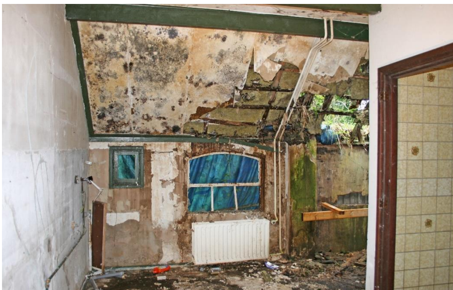
Overzicht van de bijkeuken, gezien richting de achtergevel. Het kleine venster links behoorde bij de WC die in de jaren '80 van de twintigste eeuw werd verwijderd ten behoeve van een nieuwe WC waarvan het tegelwerk geheel rechts op de afbeelding zichtbaar is. Het venster behoort tot de oorspronkelijke opzet van de in het tweede kwart van de twintigste eeuw opnieuw opgetrokken achtergevel van de stal.
