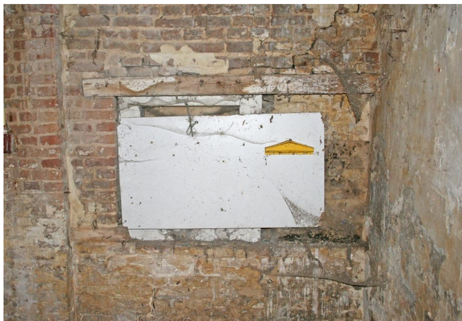
Zicht op het venster rechts van de deeldeuren in de voorgevel. Het huidige venster is opgenomen in een bredere sparing aan de binnenzijde van de gevel die aan de onder- en bovenzijde is voorzien van een houten latei. De gevel is circa 25 cm dik, hetgeen overeenkomt met anderhalf steens metselwerk. De binnenzijde lijkt uitgevoerd in een ten opzichte van de gevelsteen meer roze steen van 16-17 x 7,5-8 x 3,8-4 cm met een 10-lagenmaat van 38,5 cm.
