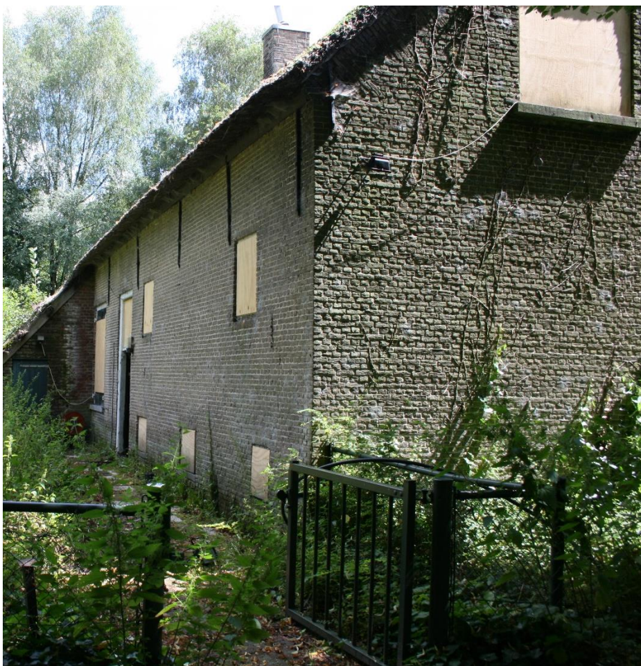
Overzicht van de achtergevel van het voorhuis.
