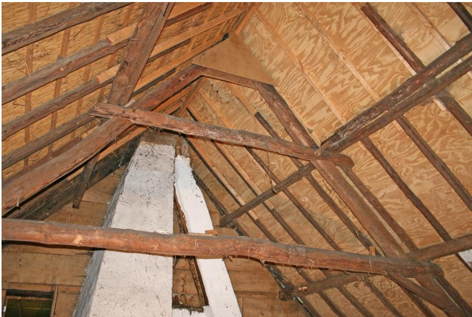
Zicht op de bovenzijde van het dekbalkjuk met daarboven het schaarspant van het tweede spant.
