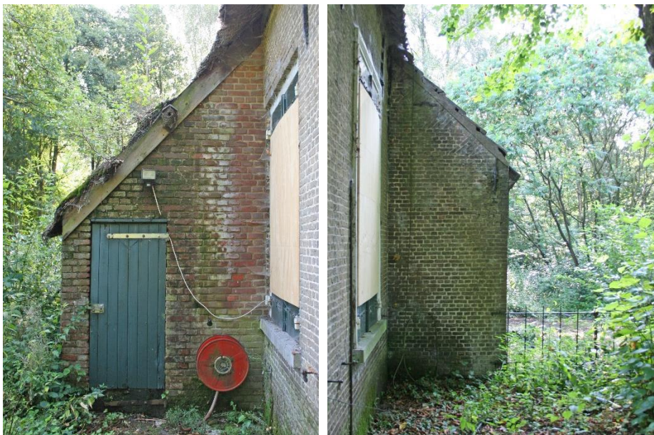
Op de linker afbeelding zicht op het linker deel van de linker zijgevel van de stal. Op de rechter afbeelding zicht op het rechter deel van deze gevel.
