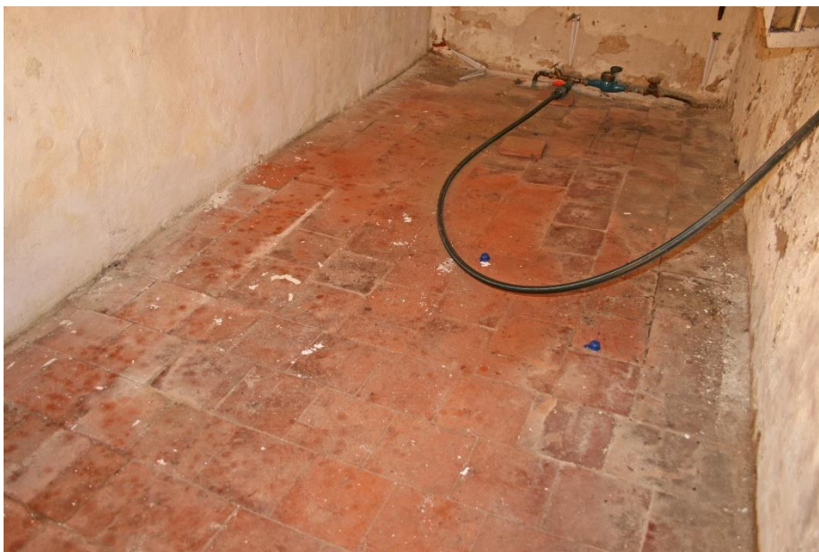
Zicht op de keldervloer van de grote kelderruimte. Halverwege de vloer wisselt de richting van de in halfsteens verband gelegde rode estrikken. Ontpleistering van het gewelf ter plaatse van deze overgang zou kunnen aantonen of er daar sprake is van een faseverschil.
