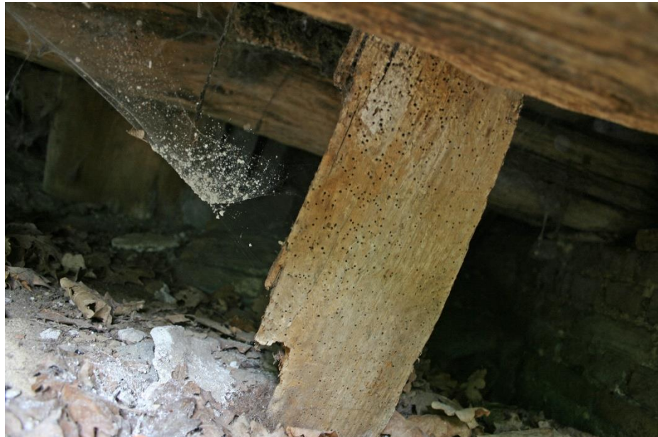
Detail van de vloer van de oven.
