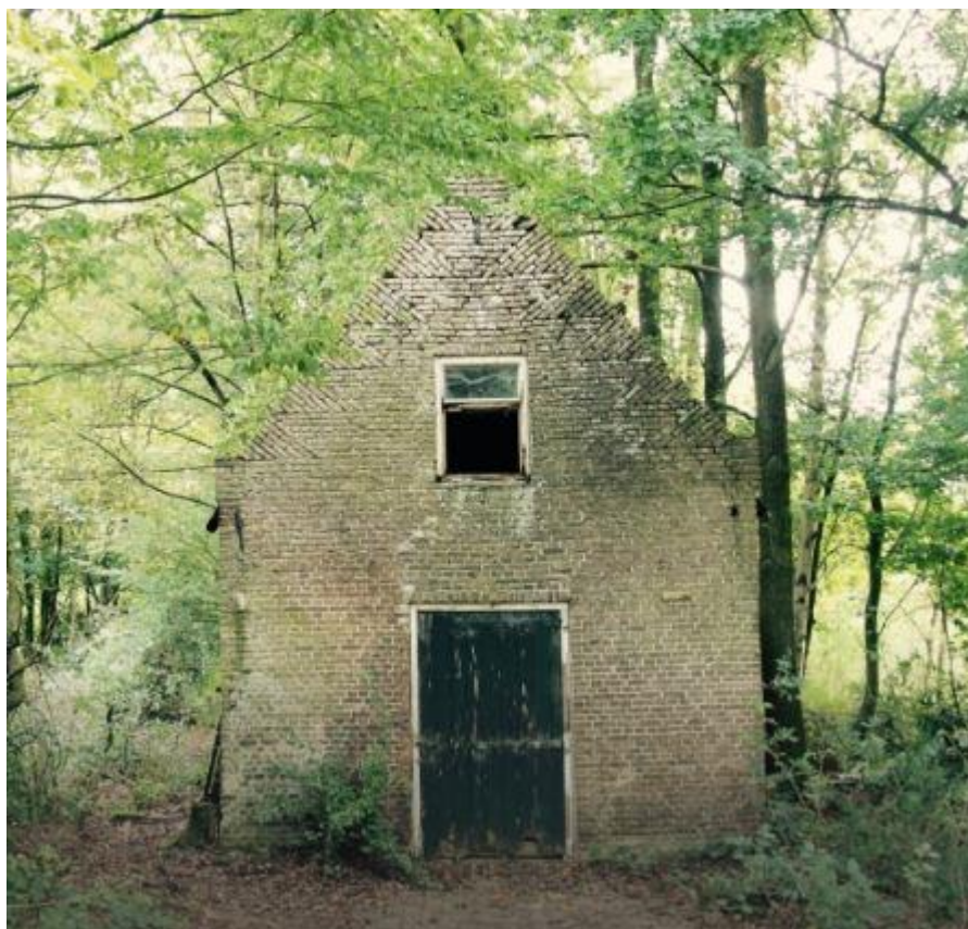
Overzicht van de voorgevel van het bakhuisje. Opname oktober 2015. Bron: BN DeStem.
