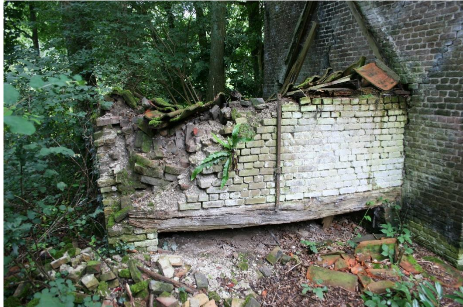
Zicht op de oven aan de achterzijde van het bakhuisje. De achterzijde hiervan bestond tot het maaiveld uit baksteen, de beide zijkanten van de oven zijn geplaatst op eiken balken. Ook de vloer bestaat uit eiken balken en delen.
