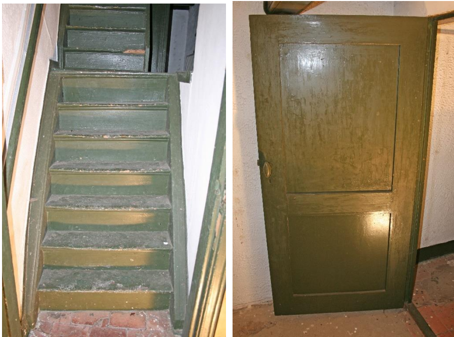
Op de linker afbeelding zicht op de trap naar de opkamer. Deze trap is schuin geplaatst ten opzichte van de wand naar de keuken, hetgeen zich aftekent in de schuine estrikken op de vloer, maar evenwijdig aan de onderliggende kelderwand. Op de rechter afbeelding de ongeprofileerde paneeldeur tussen de overloop en de opkamer.
