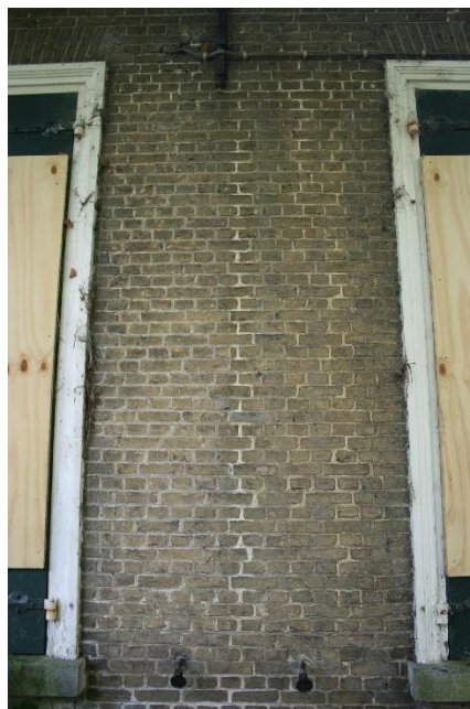
Op de linker afbeelding zicht op linker vensters in de voorgevel. De witte lijn met wat uitgespoeld voegwerk tussen de vensters werd waarschijnlijk veroorzaakt doordat de open staande luiken een deel van de weersinvloeden van de gevel weerden. Het metselwerk van deze gevel lijkt oorspronkelijk ten opzichte van de plaatsing van de vensters. Op de rechter afbeelding zicht op het metselwerk boven de voordeur met daarboven de muurplaat die geheel in het zicht is onder het secundaire pannendak.
