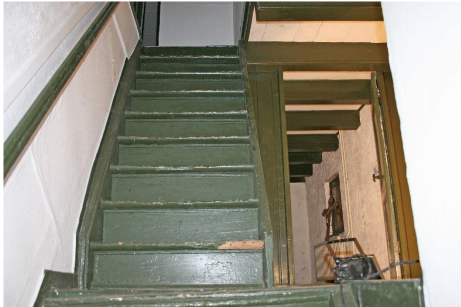
Zicht op de trap vanuit de opkamer naar de verdieping. Deze trap kent een afwijkende detaillering ten opzichte van de trap naar de opkamer en dateert vermoedelijk uit het einde van de negentiende of begin van de twintigste eeuw. Ten behoeve van de doorgang werd één van de balken doorgezaagd en niet voorzien van een noemenswaardige raveling.
