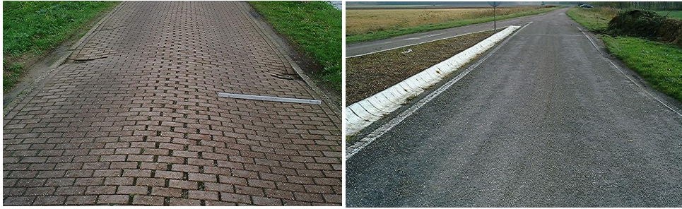
Figuur B-2 Schades dwarsonvlakheid en rafeling
