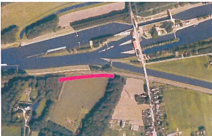
Afbeelding 2.4 Locatie drainageconstructie zuidzijde Sluis Eefde
