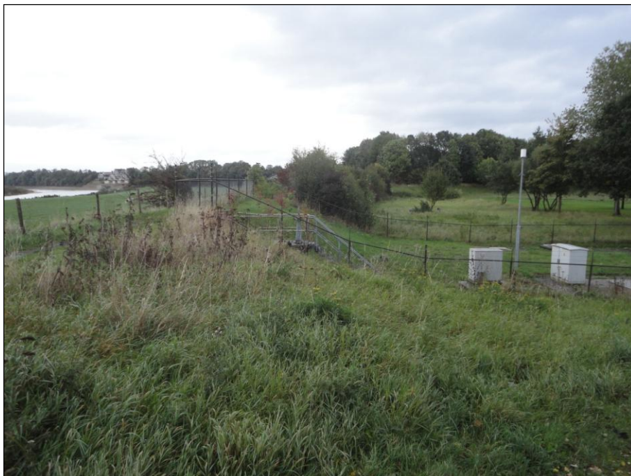
Figuur 14: Dijkvak 50.420.2, kijkend in noordwestelijke richting.
