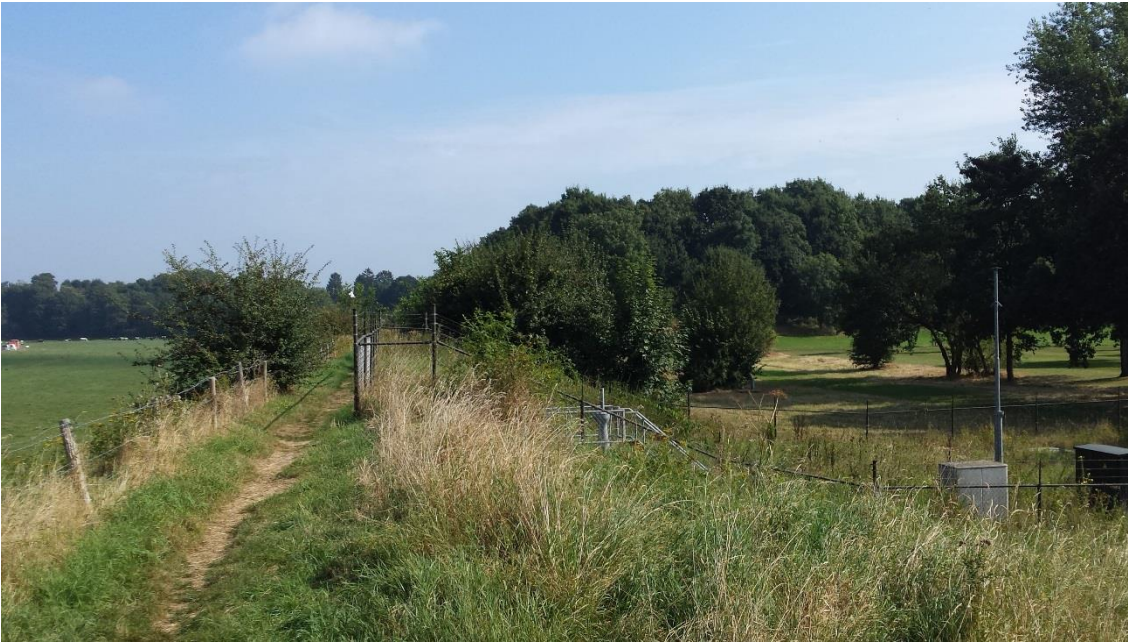
Figuur 15. Urmond. Zicht op dijklichaam en binnendijs gelegen parkzone. Kijkend in noordelijke richting.
