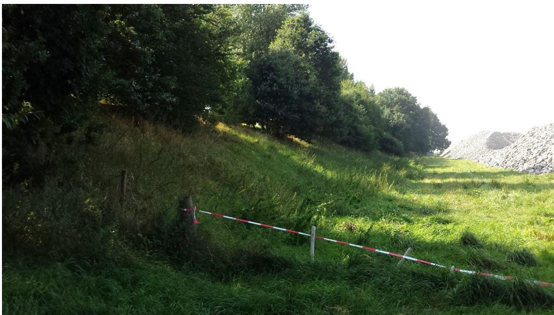
Figuur 14. Urmond. Zicht op dijklichaam vanaf het winterbed van de Maas.
