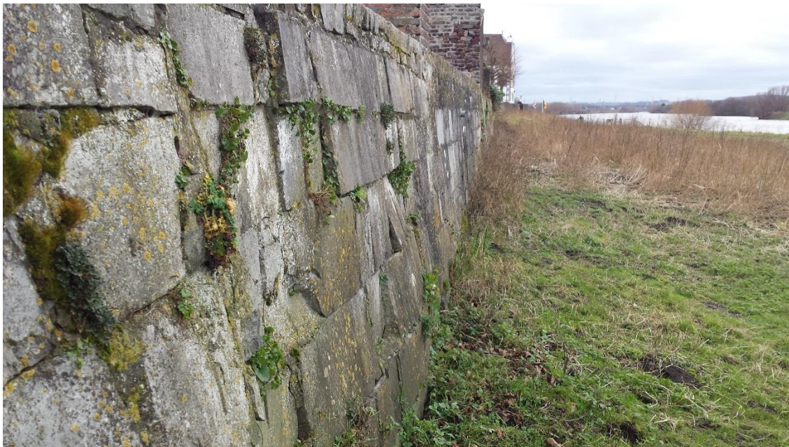
Figuur 3 Historische kademuur met broze voegen en spleten geschikt als groeiplaats voor muurflora en schuilgelegenheid voor muurhagedis.
