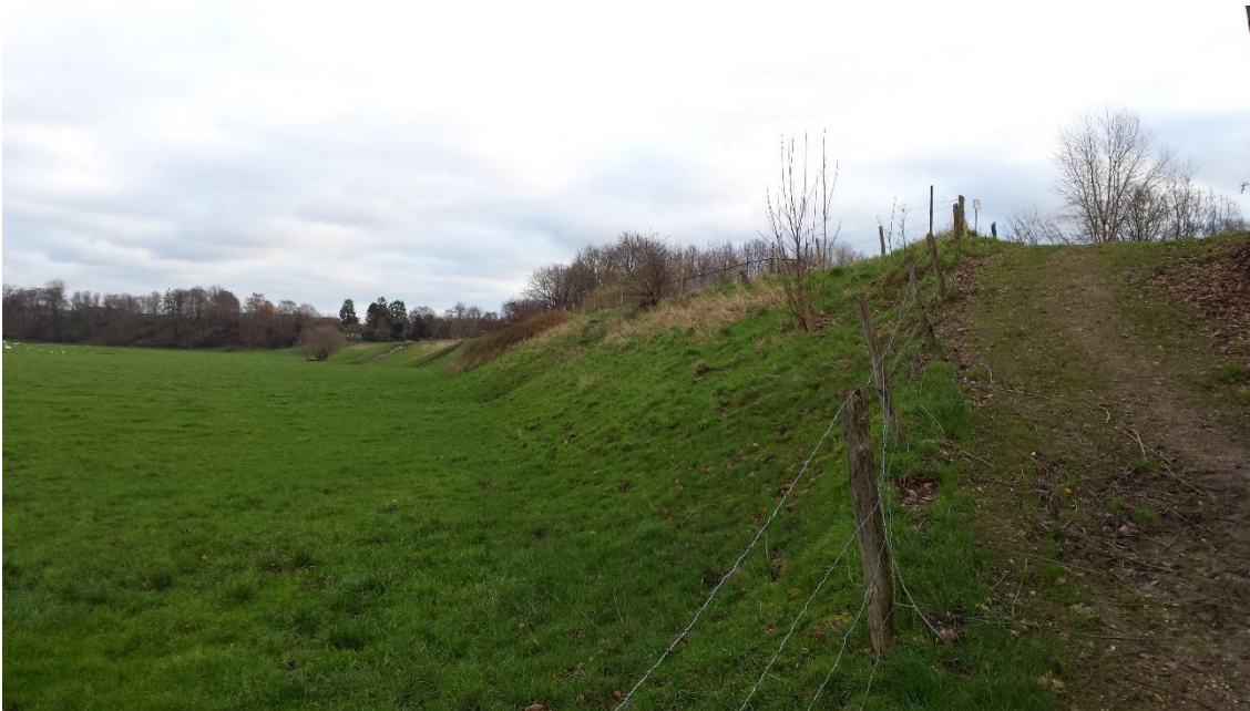
Figuur 15 Dijklichaam grenzend aan intensief beheerd weiland in het winterbed van de Maas. Op het dijklichaam een meer extensieve kruidenrijke grasvegetatie met een dicht braamstruweel en opslag van o.a. gewone es en eensteilige meidoorn.
