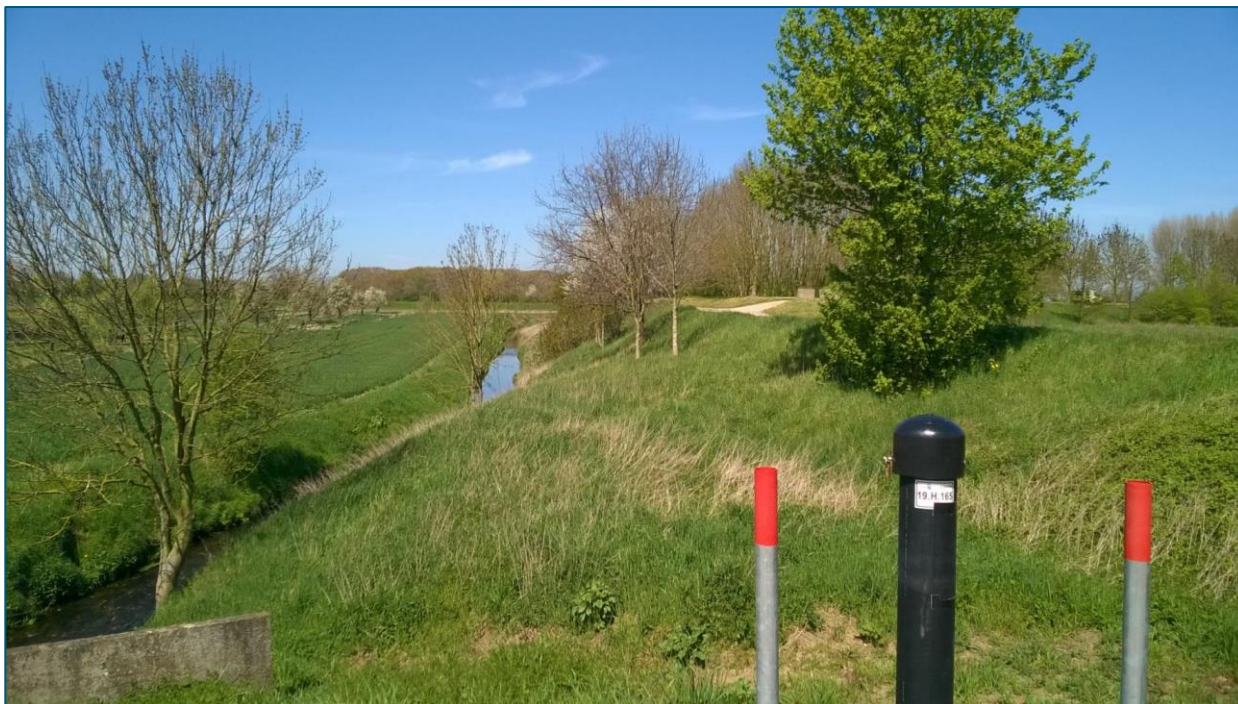
Figuur 4.4: Foto dijkvak 50.420.1: Steile dijktalud met overgang naar de Ur (rivier).
