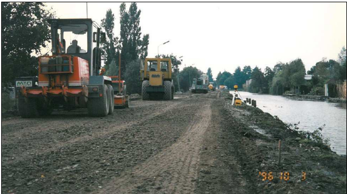
Figuur 2, werkzaamheden aan de Stommeerkade in '96
