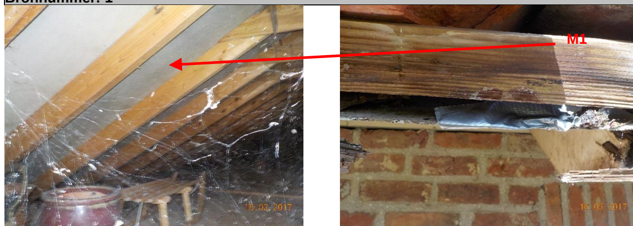
M1: dakbeschot op de schuur
