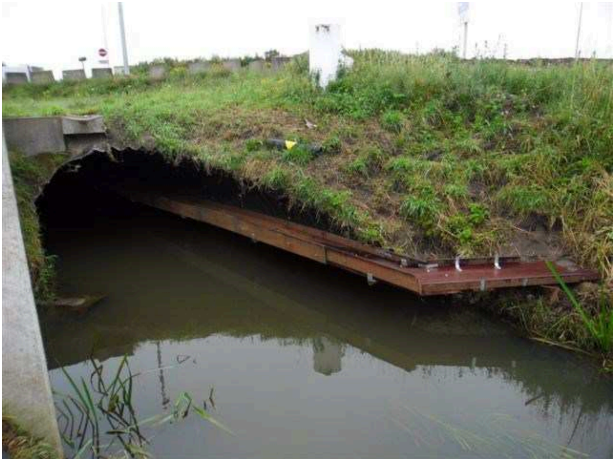
Reeds aangelegde faunapassage onder de A16/HSL direct ten zuidoosten van het plangebied.
