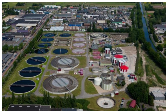
RWZI Apeldoorn: energie- en grondstoffenfabriek
