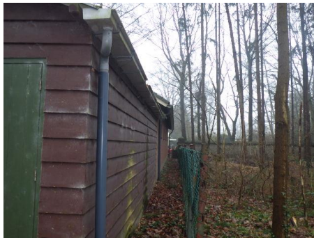
achterzijde schuur met grensafscheiding / Foto 2
