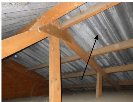
binnenzijde dakconstructie schuur / Foto 4
