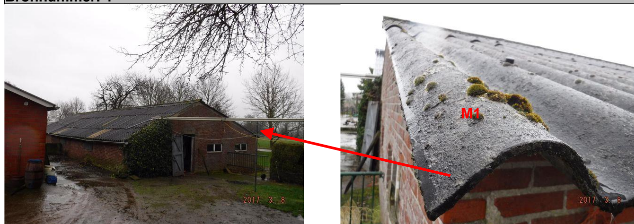
Golfplaten op dak van varkensschuur.
