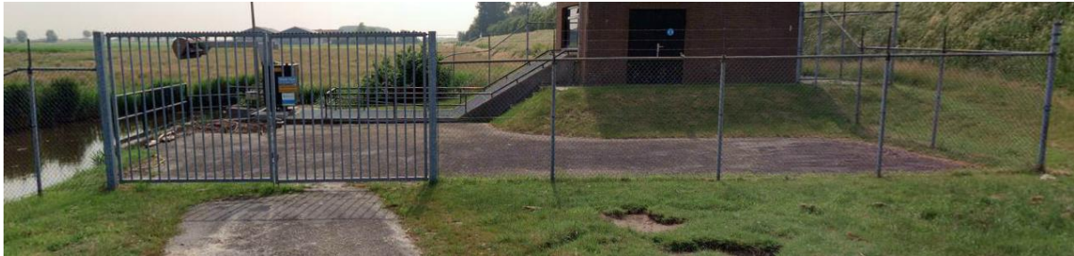
Foto 1: Huidig hekwerk gemaal Visvliet
