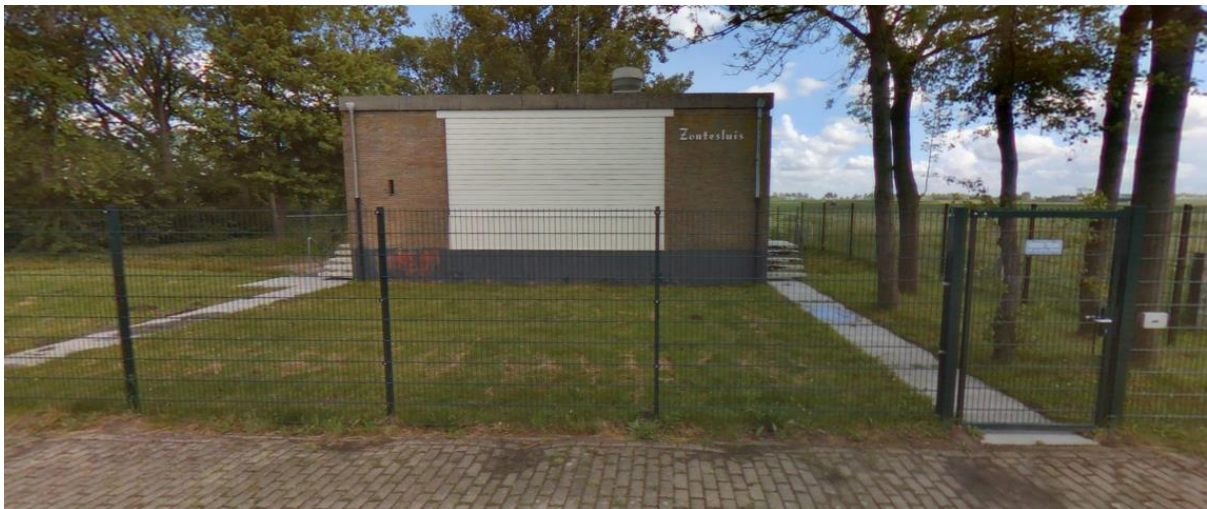
Foto 2: Huidig hekwerk gemaal Zoute Sluis
