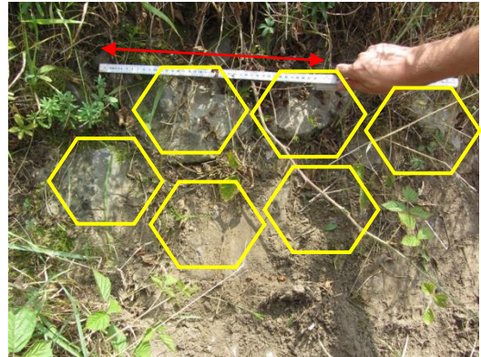
Figuur II-6 Zetsteen op driekwart van het talud bij 34,5 (rode pijl = 40 cm)
