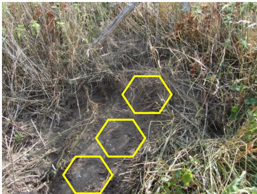
Figuur II-7 Zetsteen bovenaan talud bij 34,5
