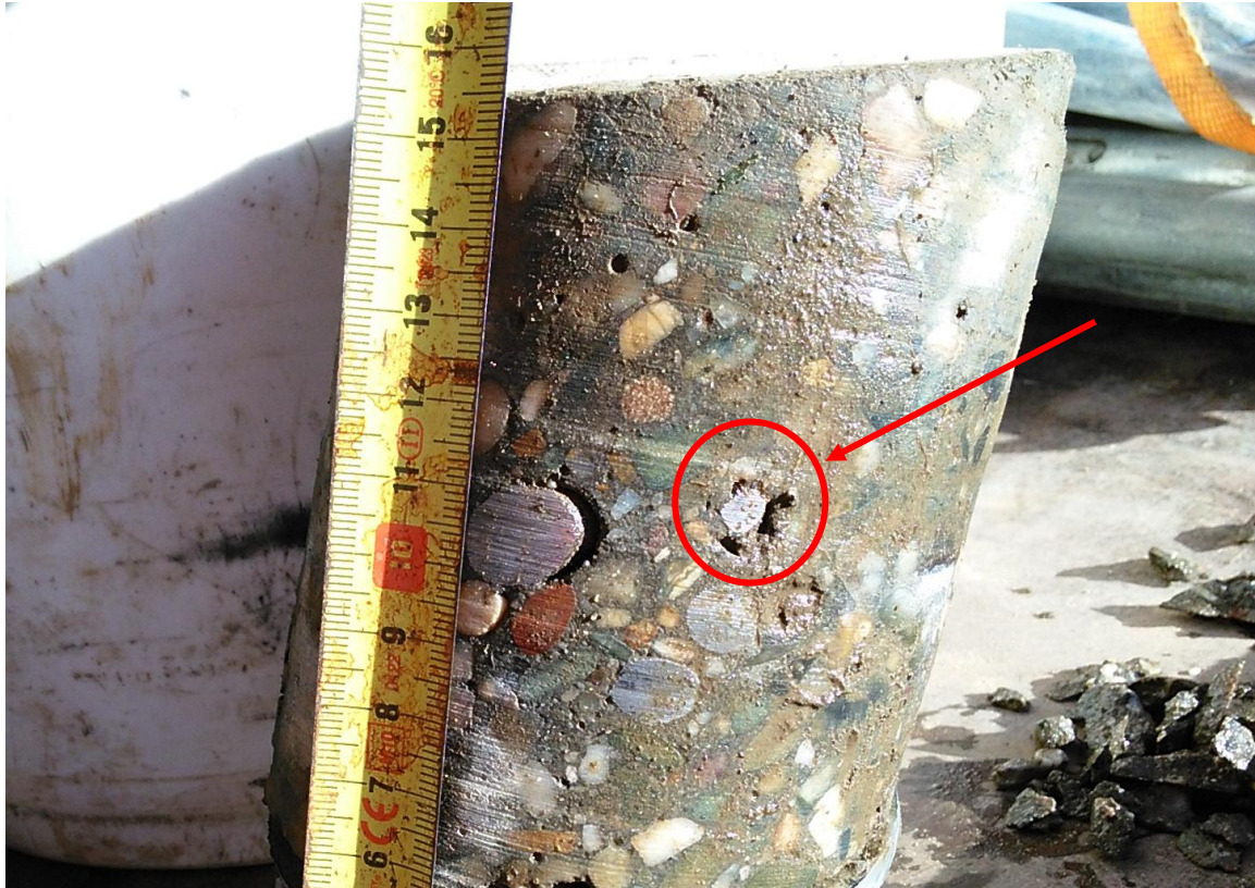
Afbeelding 2.2 Foto van de boorkern (wapeningsstaaf in midden)
