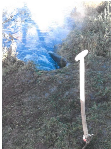
Afbeelding 2, Overzicht boorlocatie na werkzaamheden
